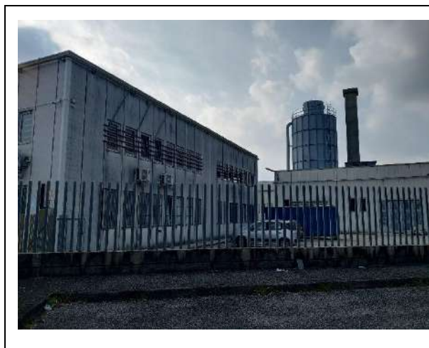
Fig. 3: vista da Via Perugia
