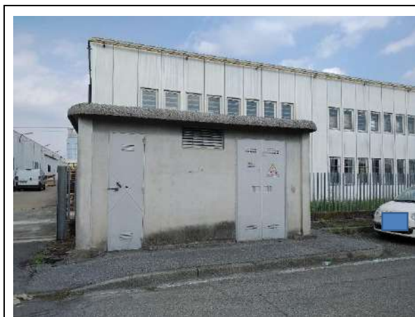
Fig. 18: cabina elettrica esterno
