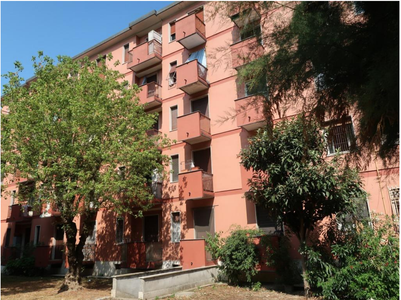
FACCIATA SUL RETRO
