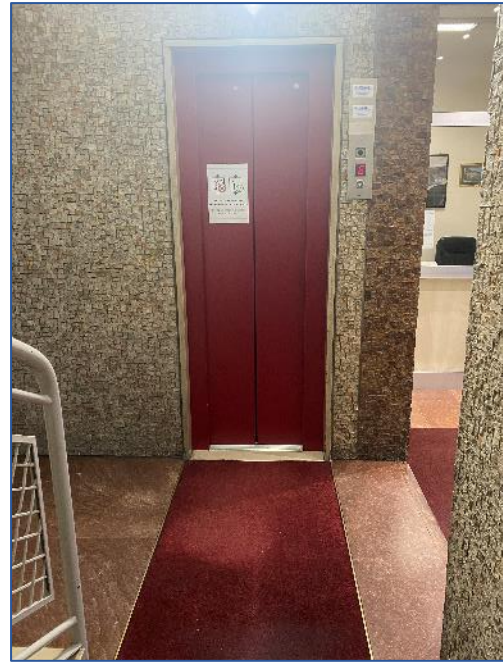
Foto 10 – vano scala comune
