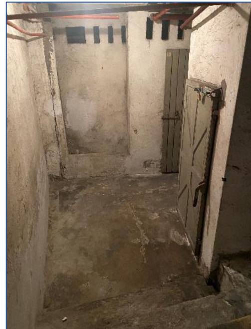
Foto 16 - corridoio comune piano S1
