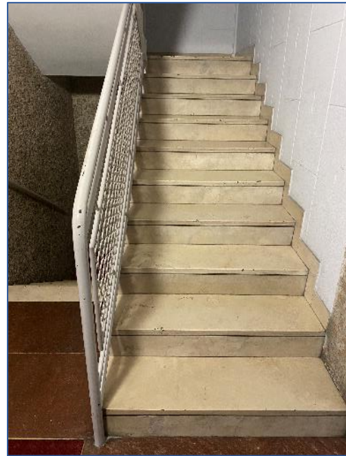
Foto 12 - vano scala comune
