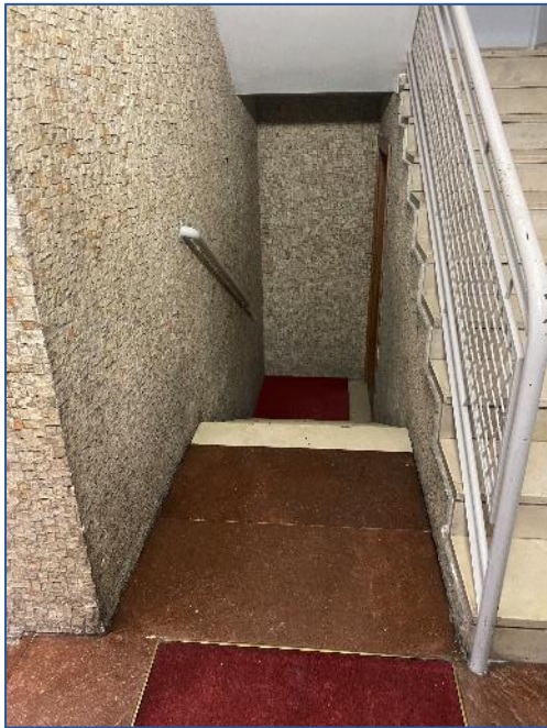
Foto 11 – vano scala comune
