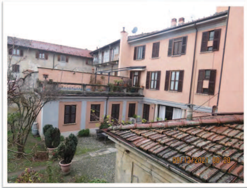
Viste dalla finestra del bagno su proprietà di terzi.
