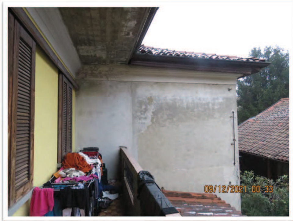
Viste del balcone al piano primo.
