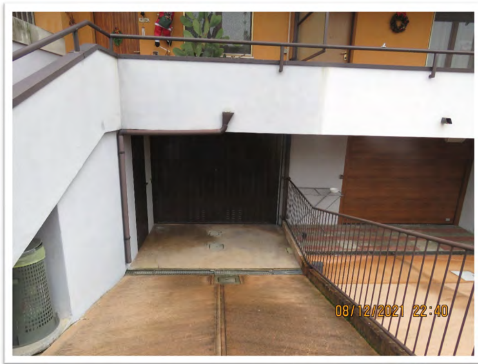
Particolare dell'ingresso dell'autorimessa (piano seminterrato) e dell'abitazione (piano rialzato).
