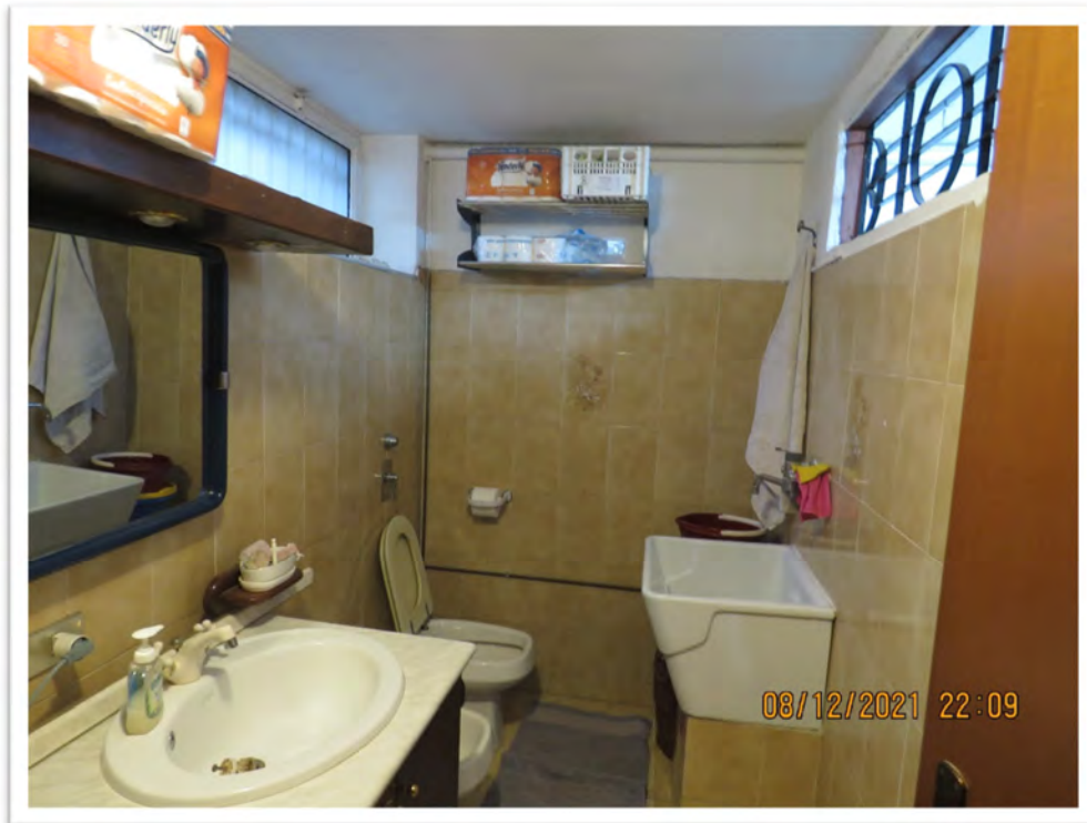
Il locale lavanderia impropriamente usato anche come bagno.
