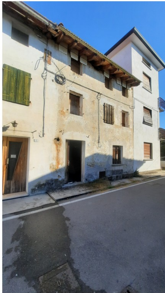
1 - fronte su via marconi
