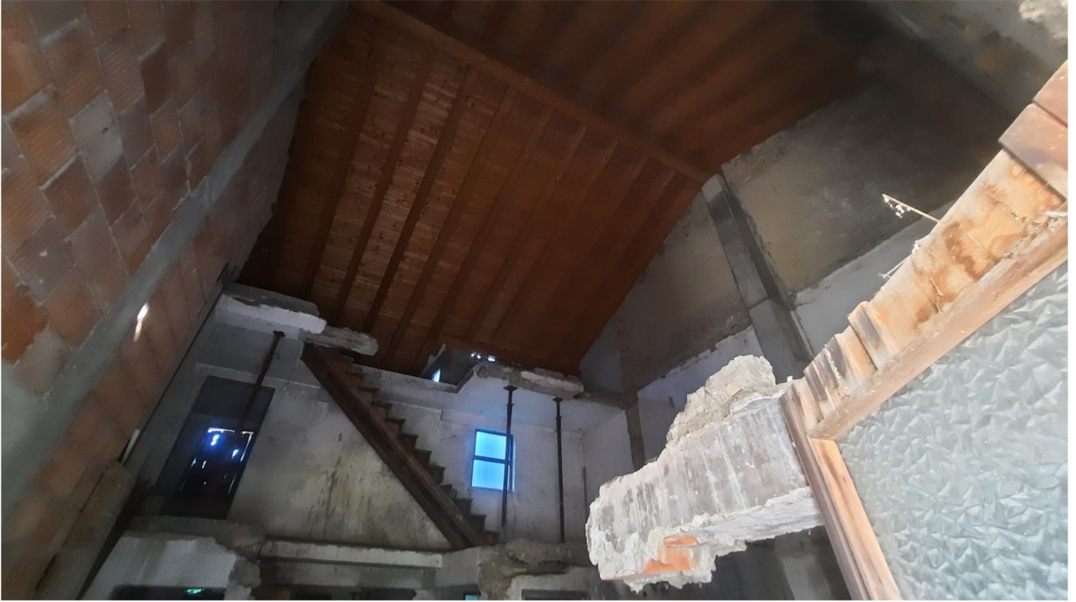
9 - interno copertura e struttura
