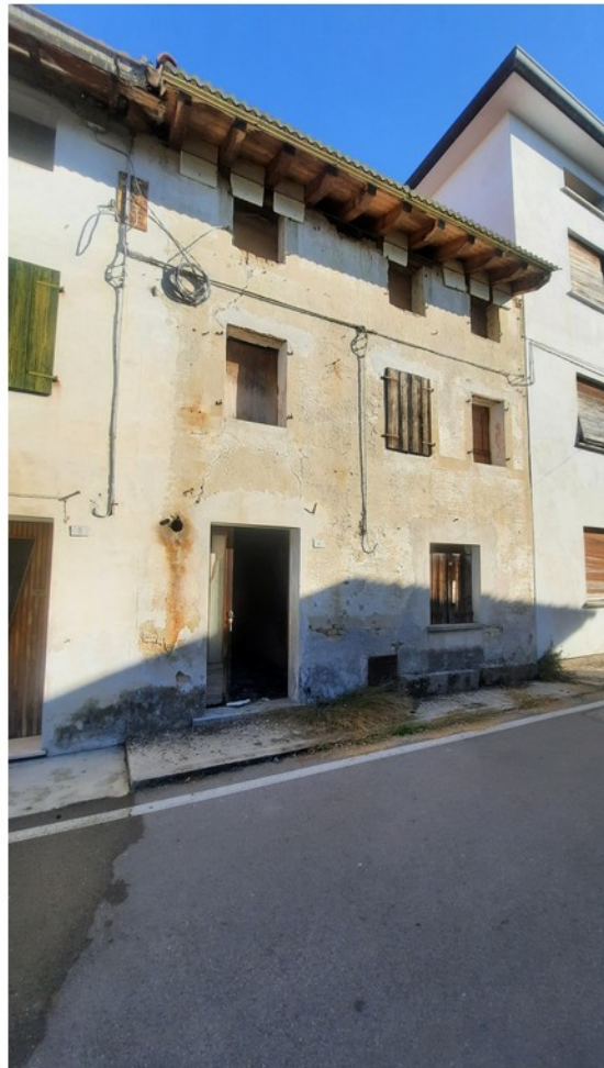
2 - fronte su via marconi
