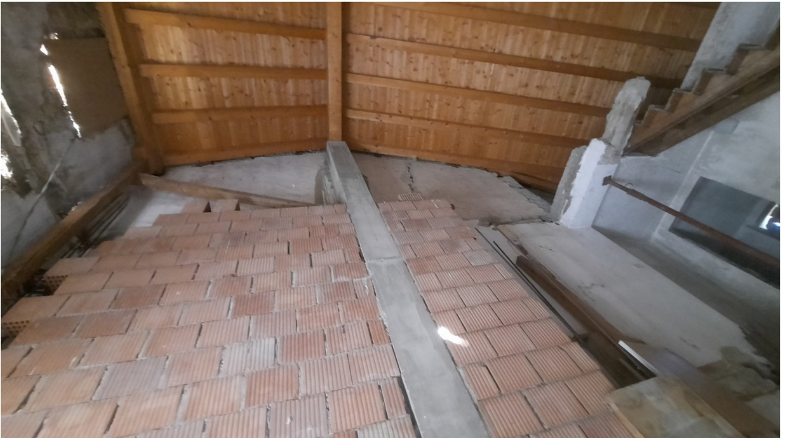
14 - copertura struttura interna
