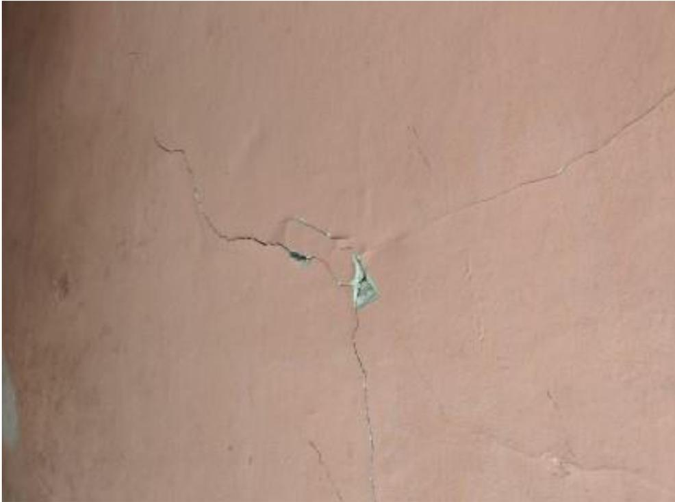
**FOTO 23:** PARTICOLARE FESSURA (Subalterno n. 4)
