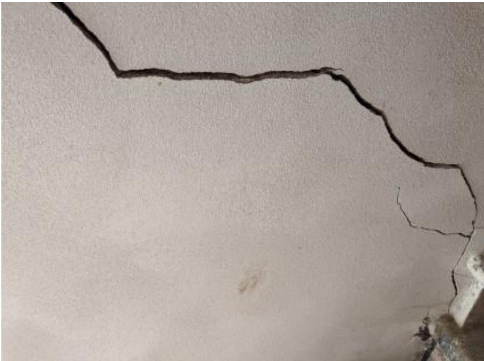
**FOTO 24:** PARTICOLARE FESSURA (Subalterno n. 4)
