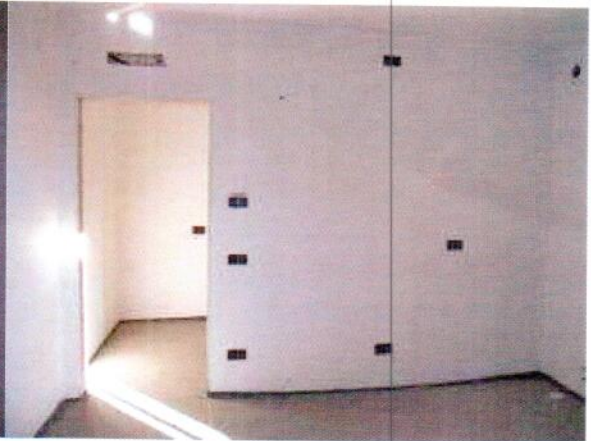
Vista verso antibagno
