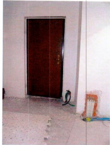
Vista verso ingresso
