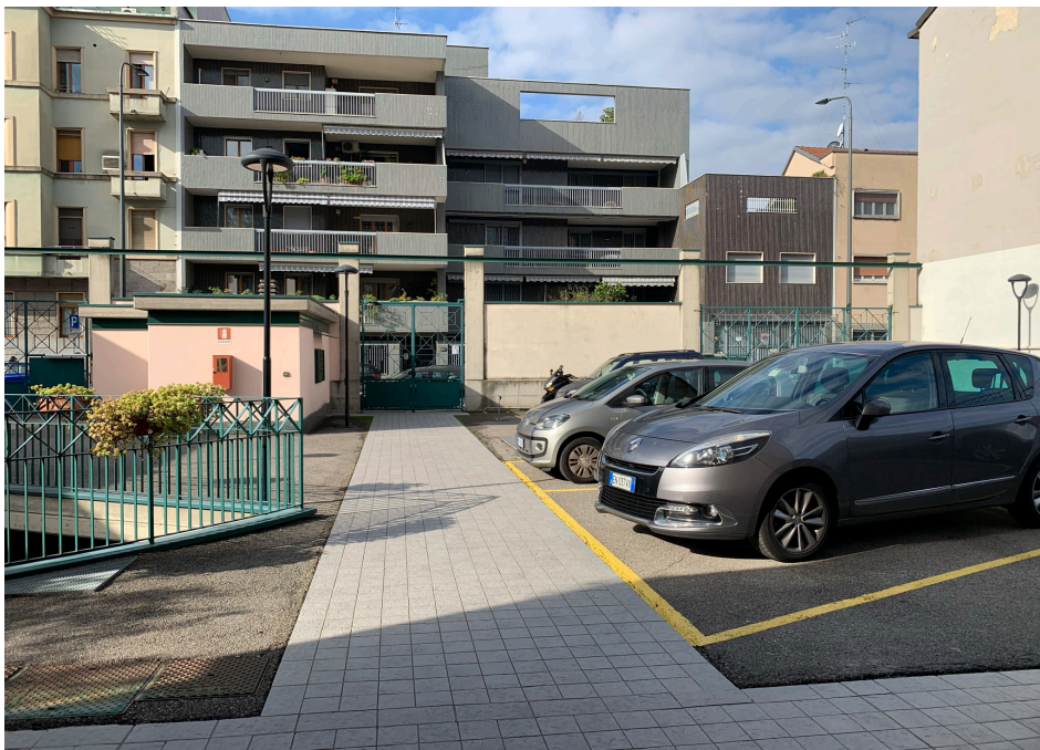
Vista esterna - ingresso condominio
