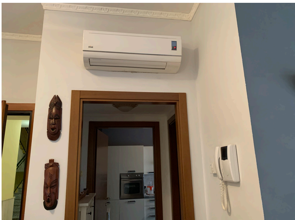
Vista interna - disimpegno
