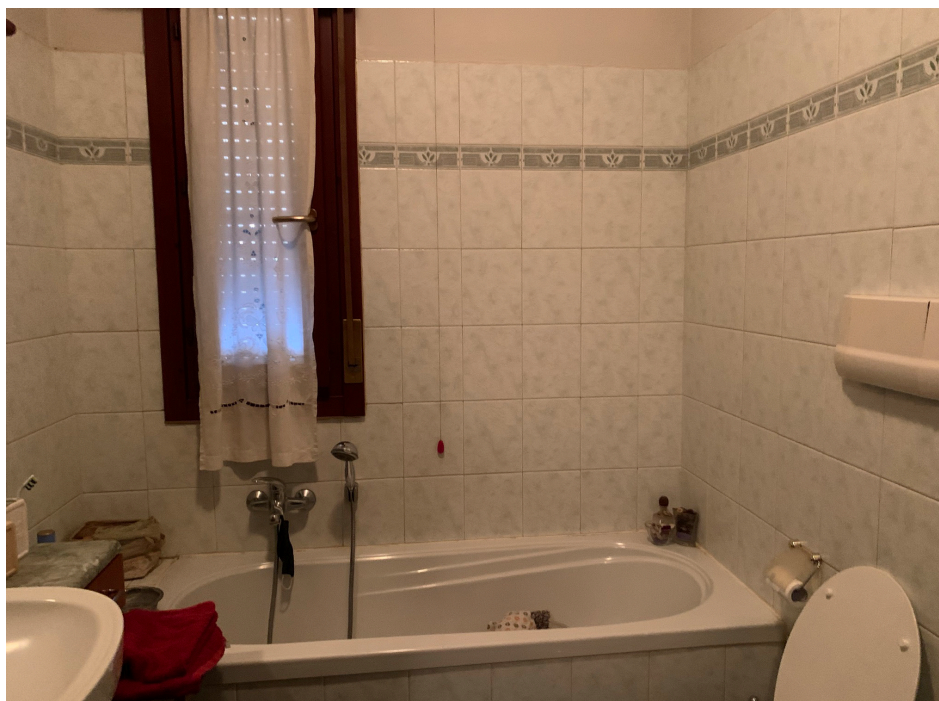
Vista esterna - bagno
