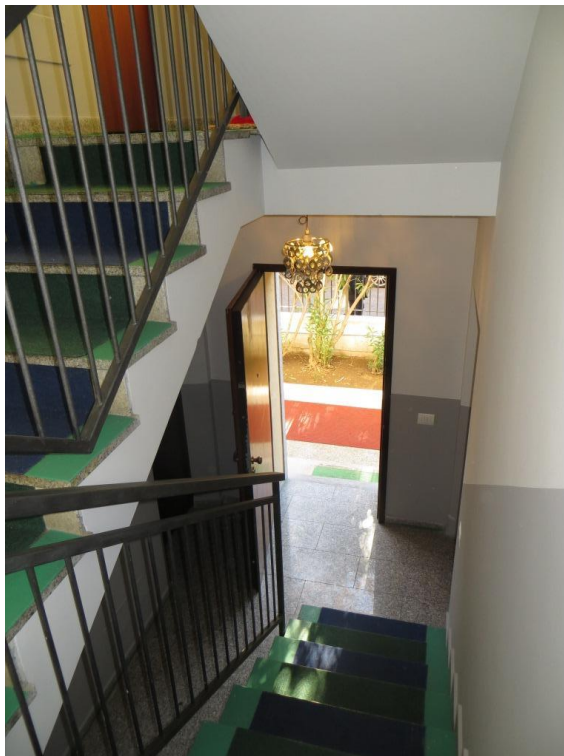
Foto 64 – Vano scala comune di accesso agli appartamenti
