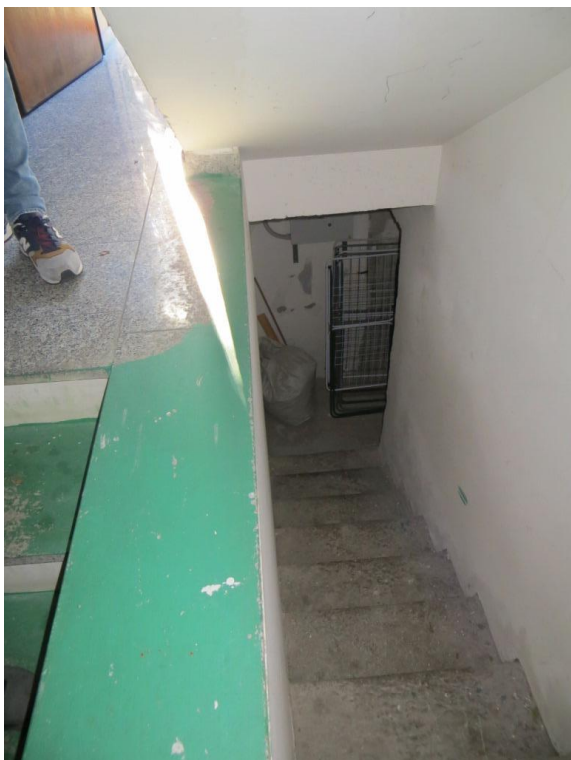
Foto 114 – Vano scala comune di accesso al piano S1
