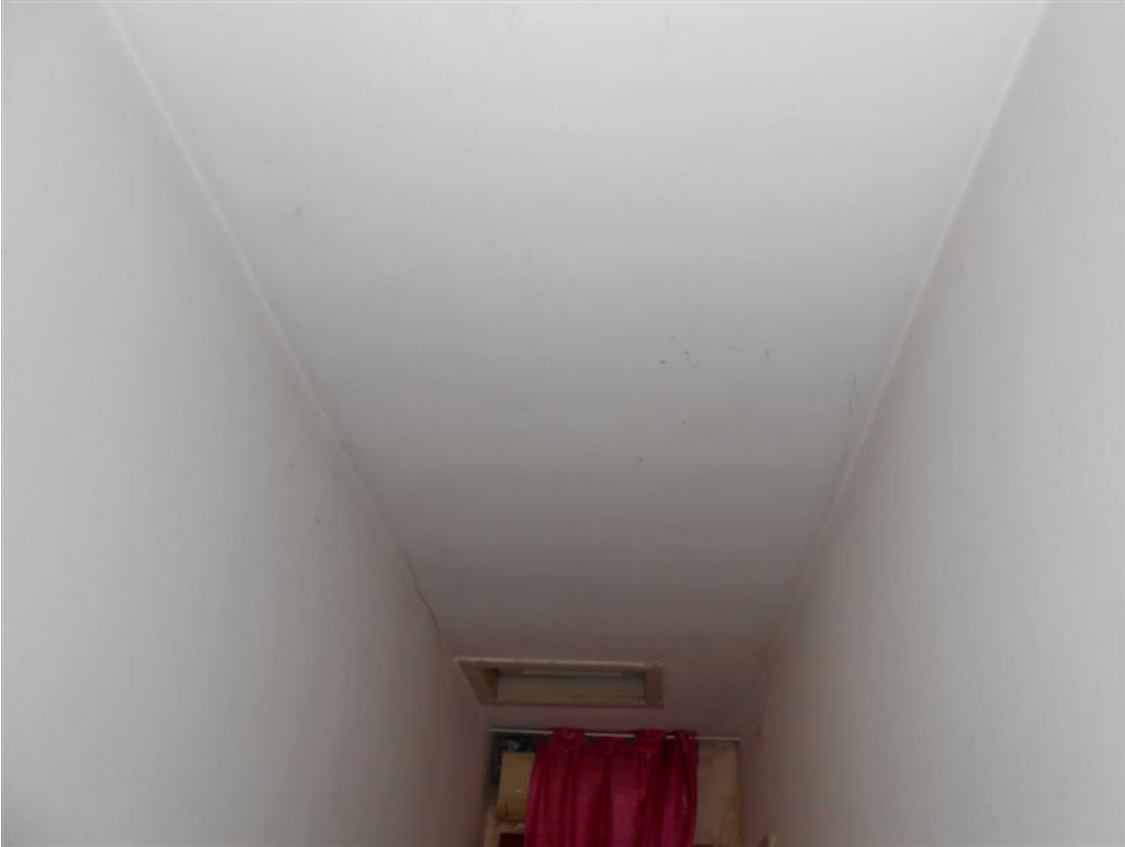
78) Particolari scala interna
