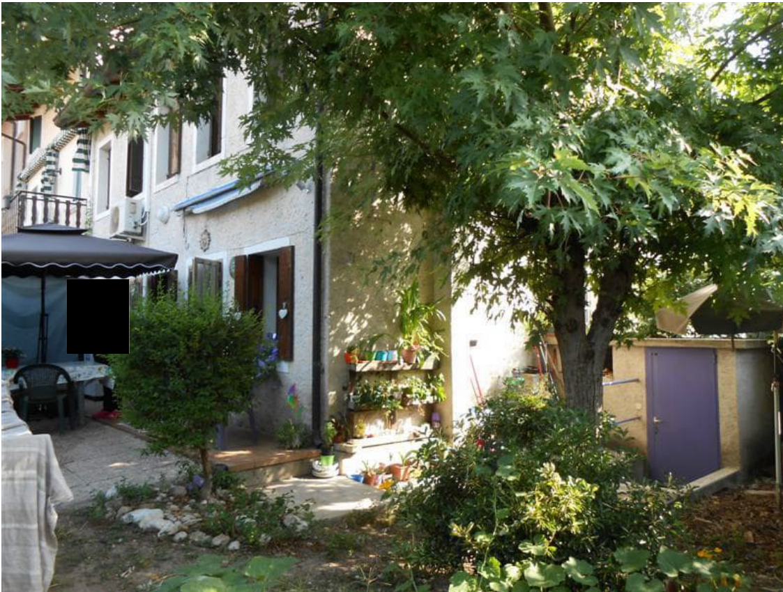
15) Vedute del giardino e della centrale termica
