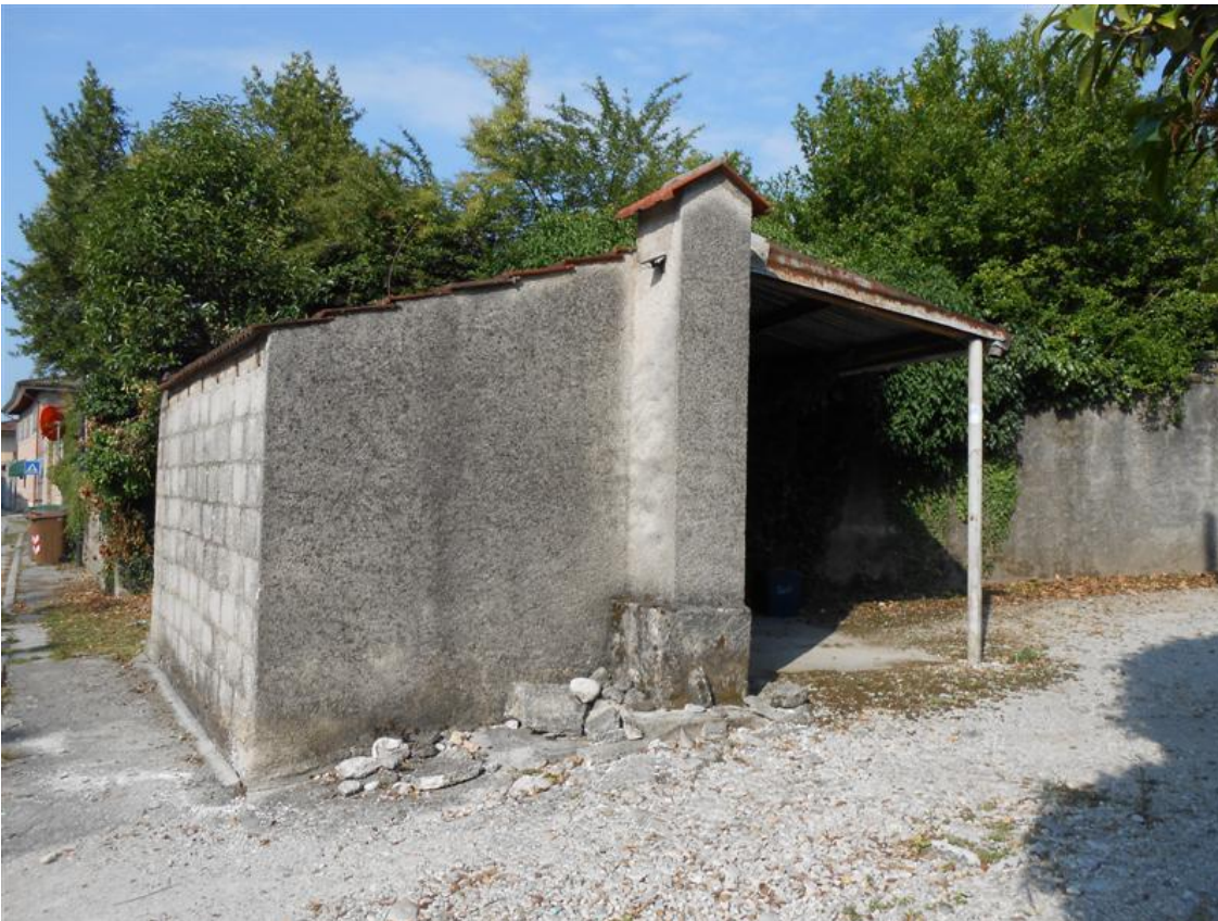
2) Veduta dell'accessorio dall'ingresso al cortile
