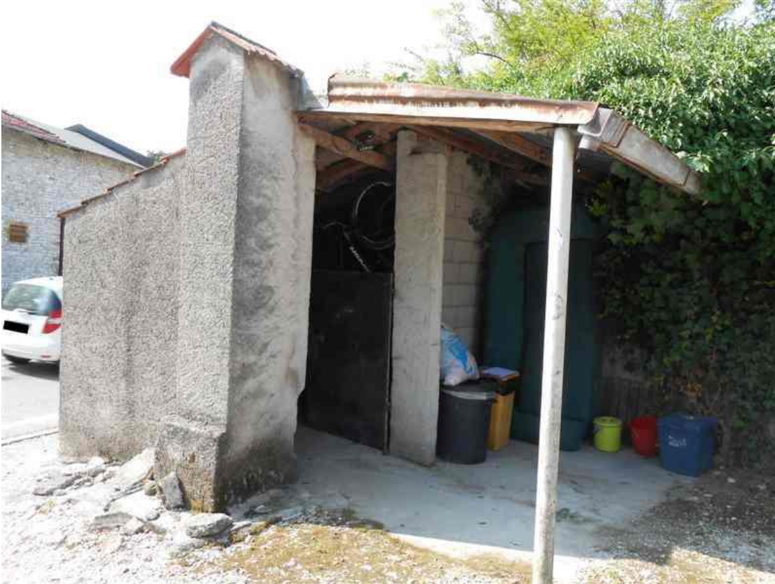
3) Accessorio adibito a deposito con antistante tettoia
