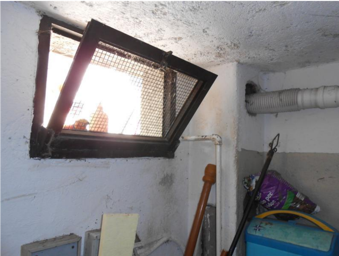
122) Particolari centrale termica
