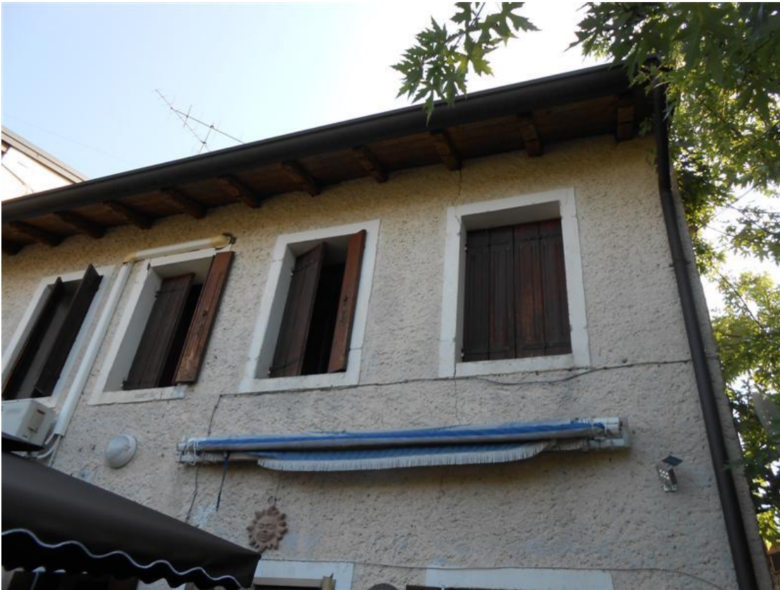
13) Particolari della facciata
