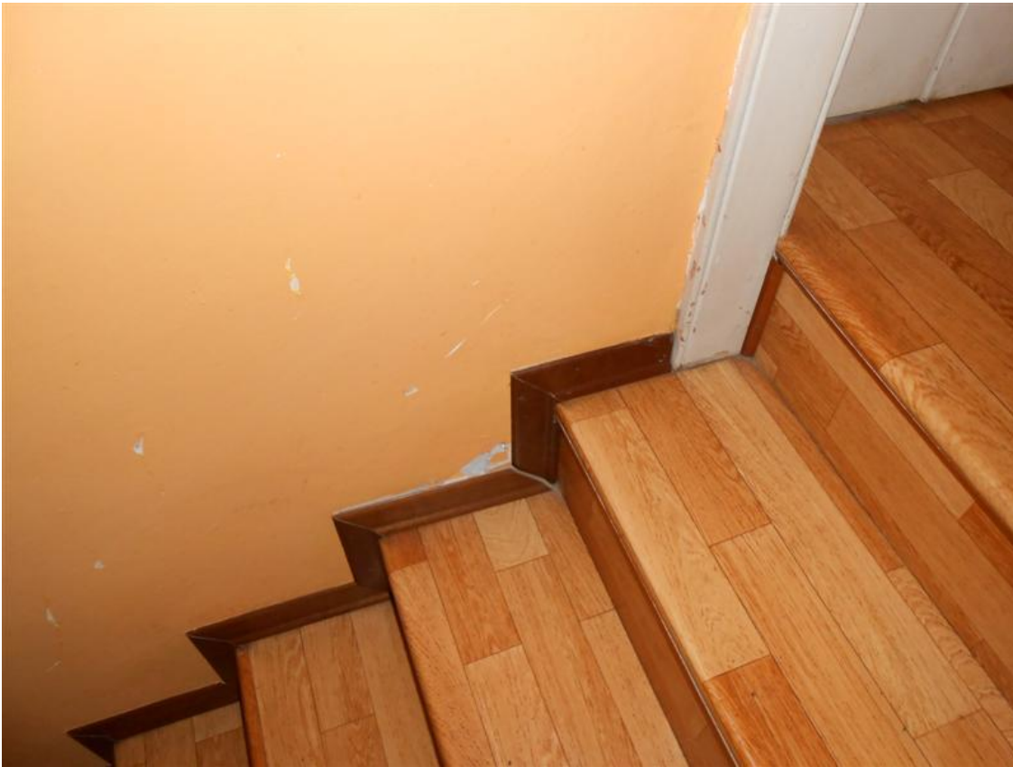
82) Particolare scala interna
