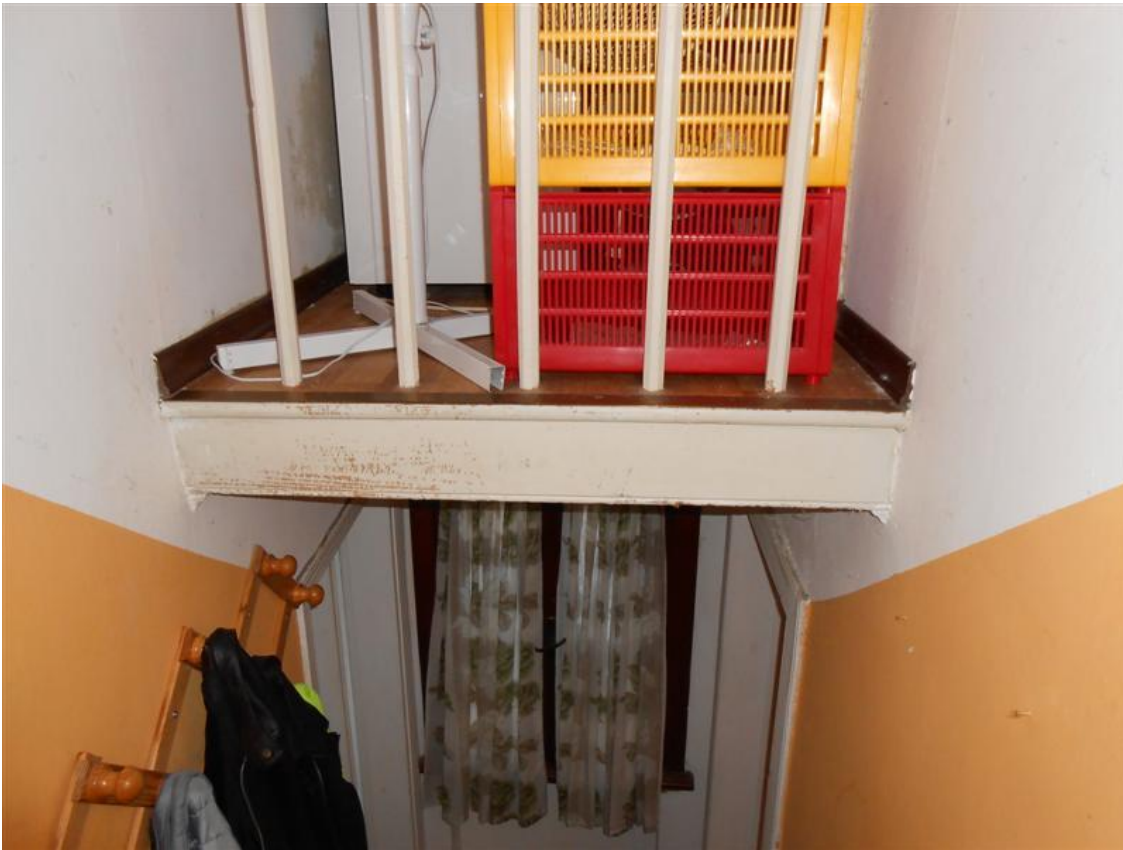
80) Particolari scala interna
