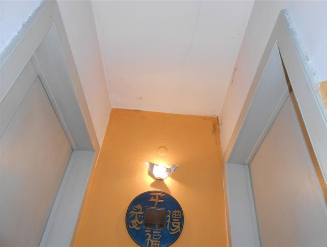
84) Scala interna: pianerottolo a quota piano primo
