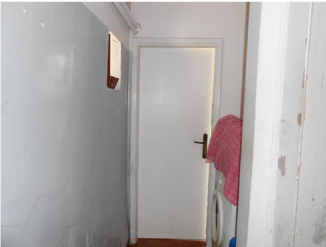
51) Disimpegno; in fondo la porta di comunicazione con il bagno
