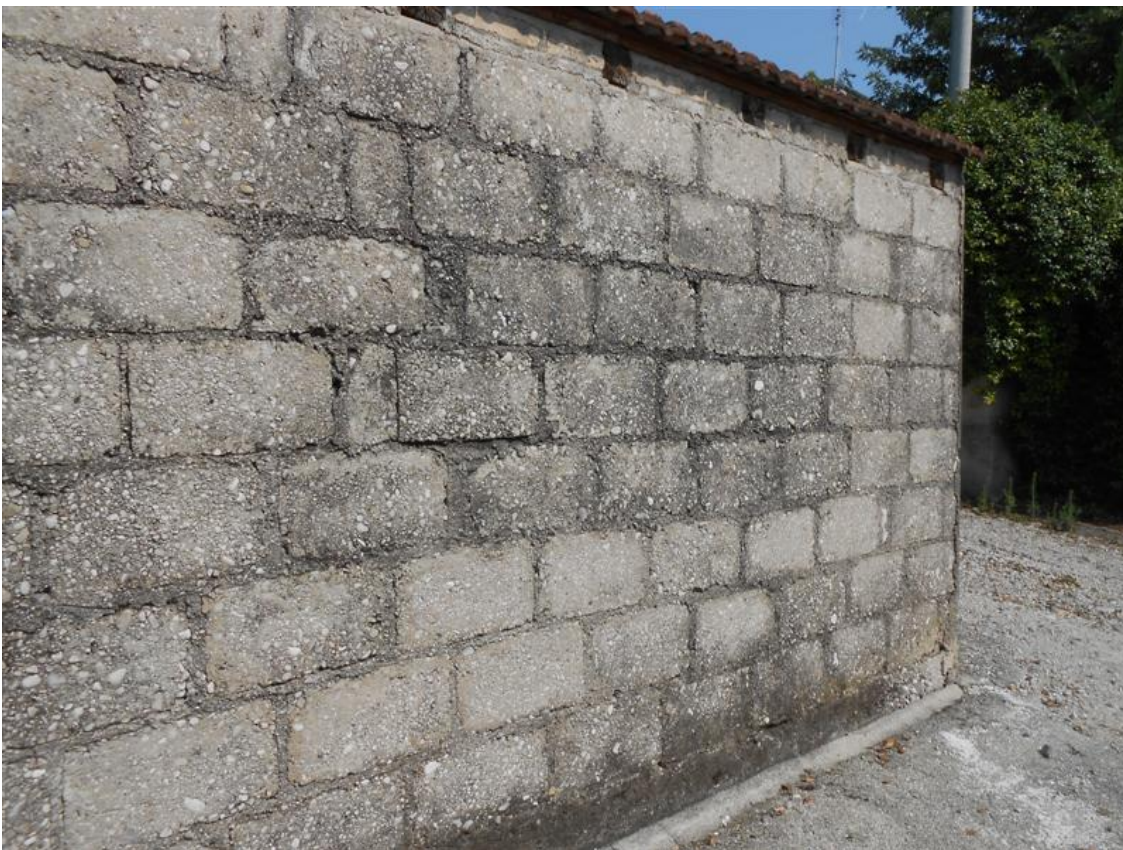
12) Fronte sulla strada
