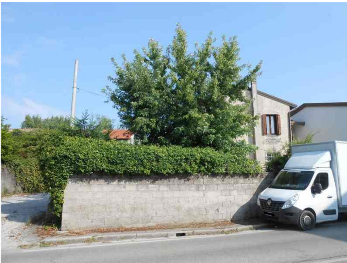
2) Muro di cinta su via Monte Grappa
