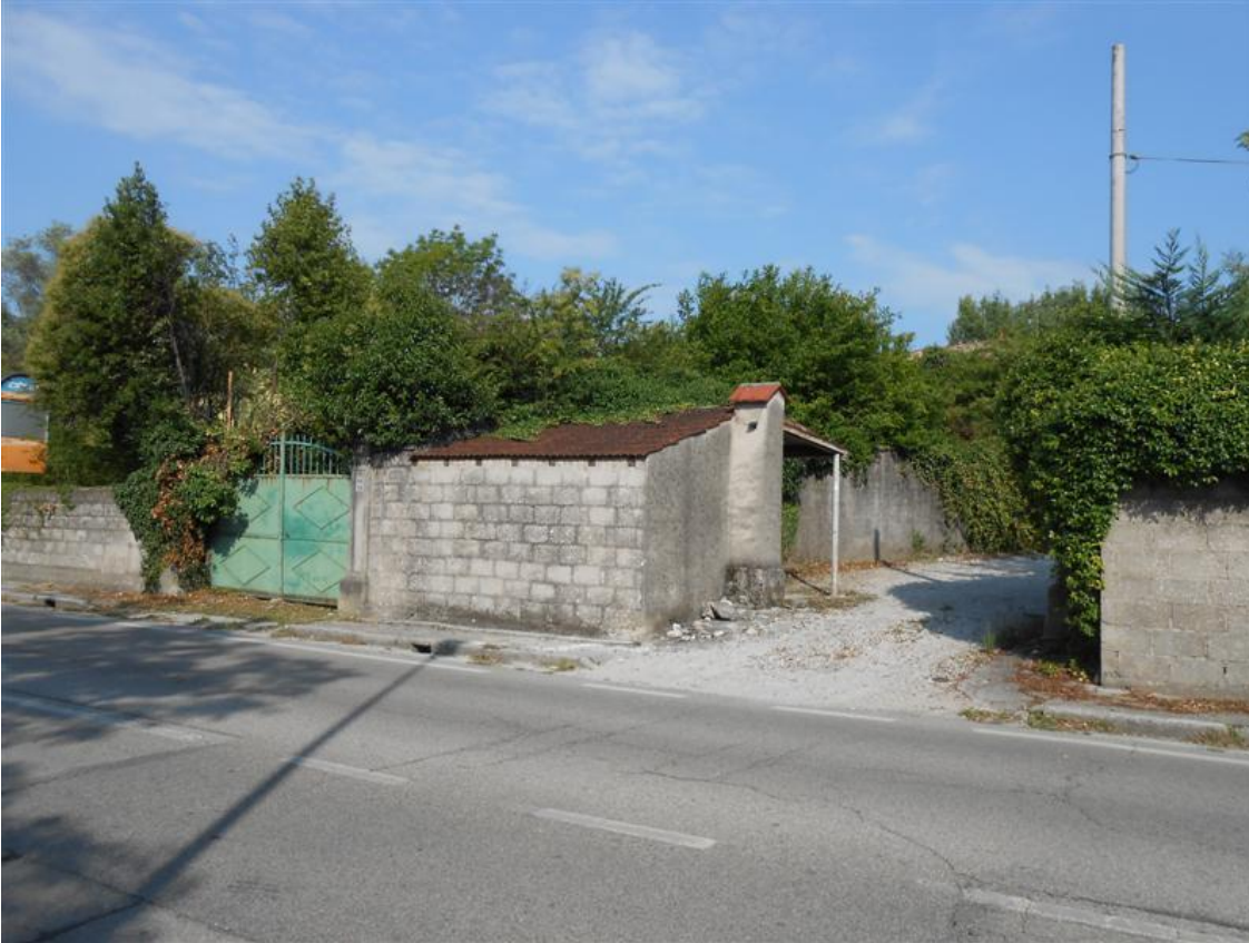
1) Veduta dalla strada via Monte Grappa
