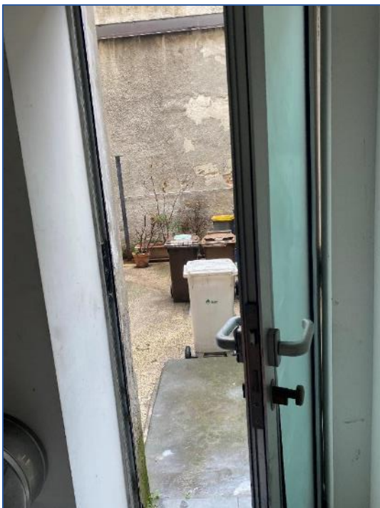
Foto 42 - accesso bagno eterno da cortile
