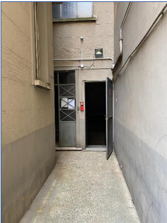
Foto 6 - accesso piano cantine da cortile
