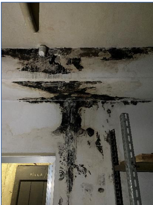
Foto 46 - dettaglio plafoni cantina
