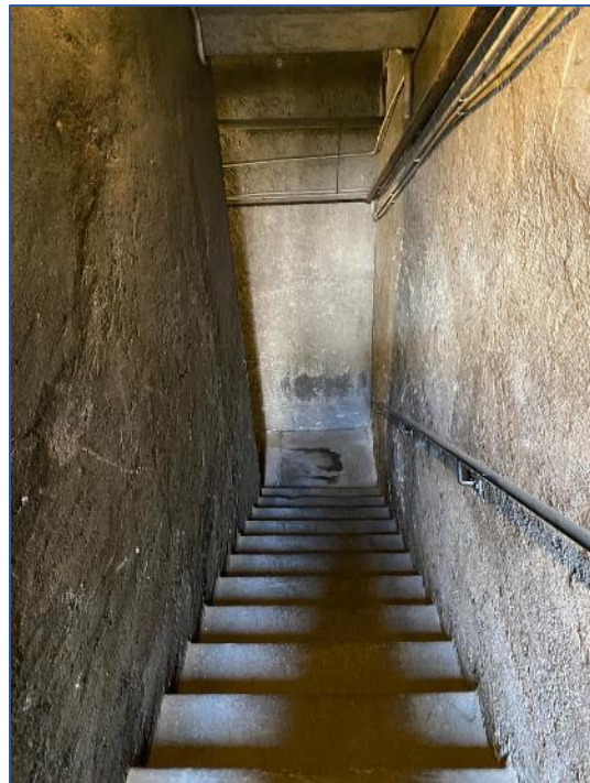
Foto 7 - scala comune per piano cantine
