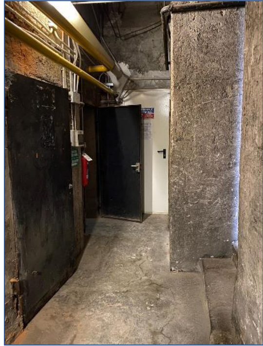
Foto 9 - corridoio comune piano cantine
