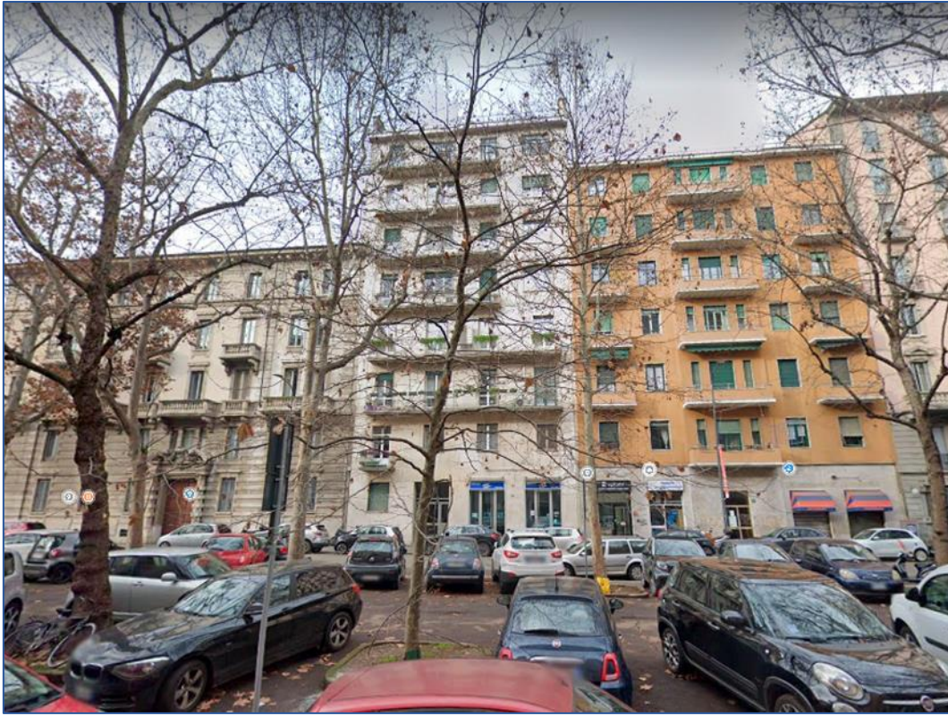
Foto 1 - immobile di via Poliziano n. 3
