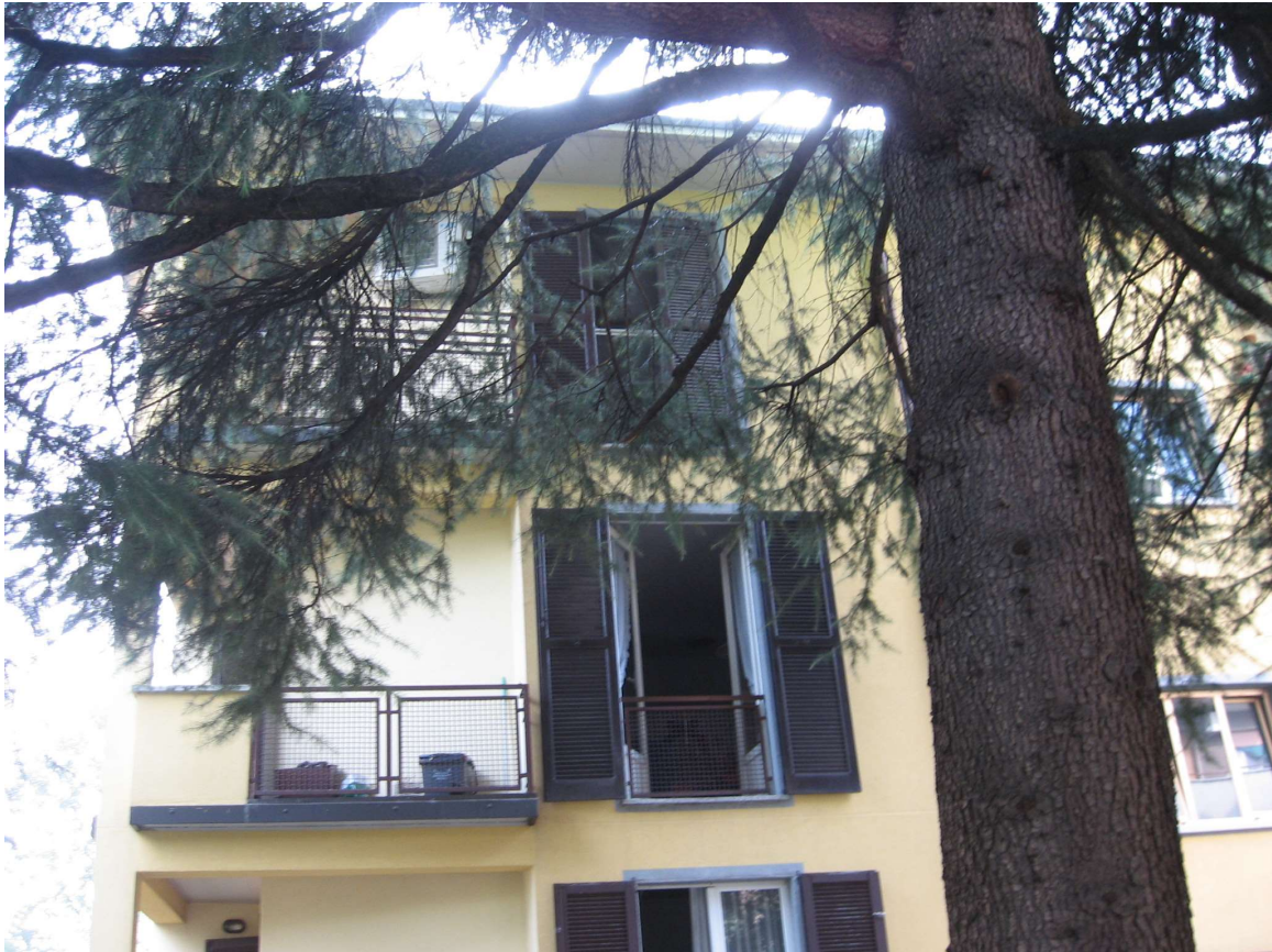
FACCIATA SU STRADA
