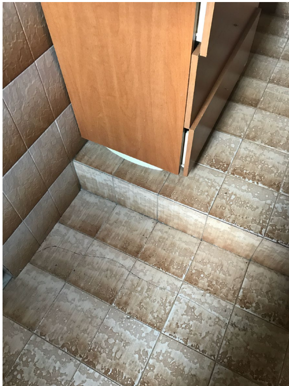
Immagini 34 e 35 Dettaglio della pavimentazione: il gradino all'interno del bagno e il leggero dislivello tra cucina e bagno.
