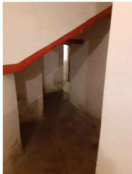
32. Passaggio comune delle cantine
