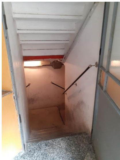
31. Scala di accesso alle cantine
