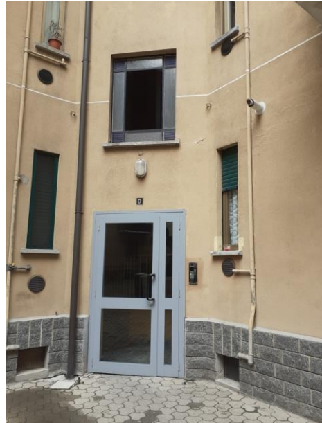
4. Accesso alla Scala D
