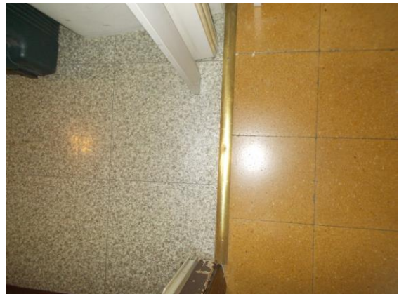
22. Dettaglio pavimenti camera e corridoio
