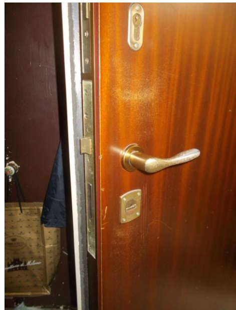
8. Dettaglio del portoncino di ingresso
