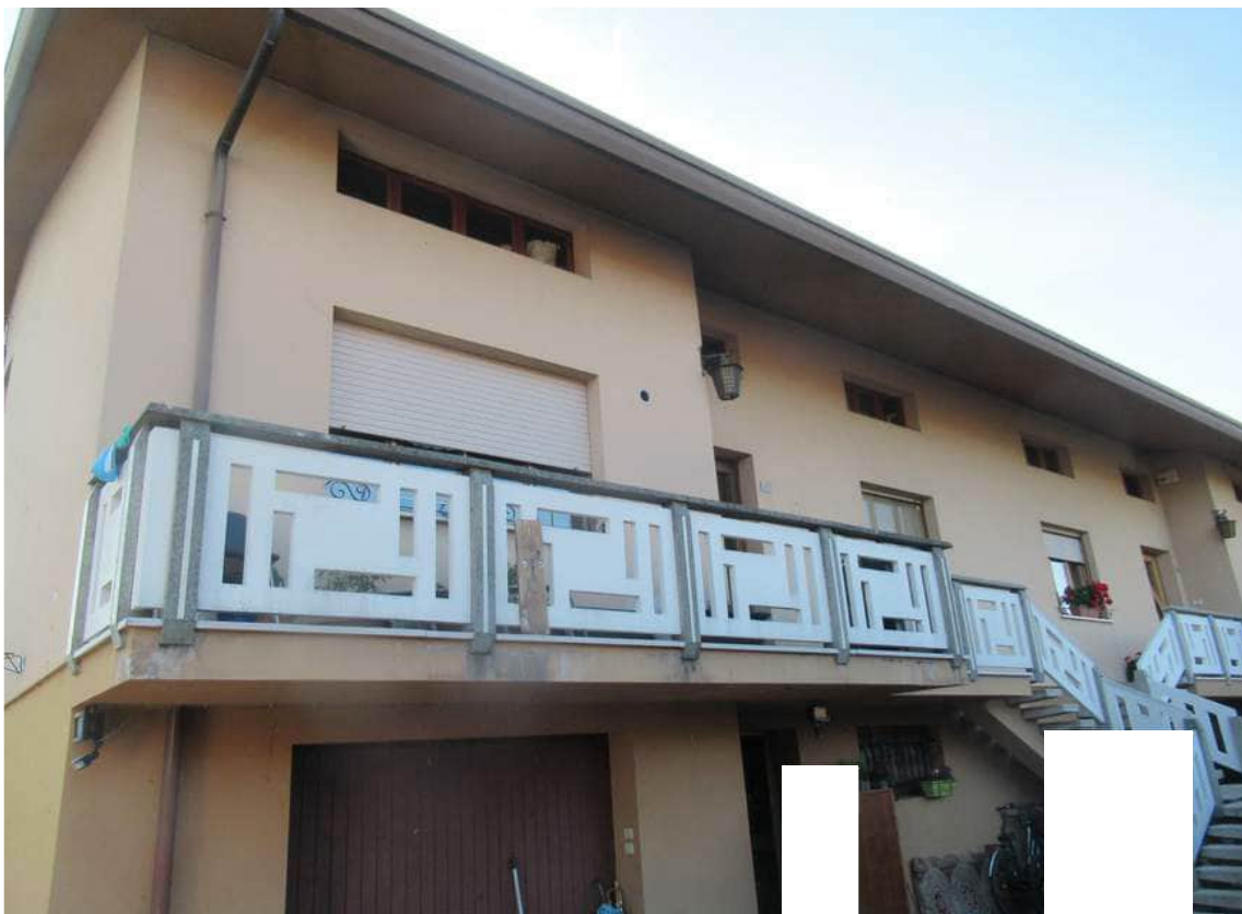
Foto 8: Prospetto Est fabbricato
