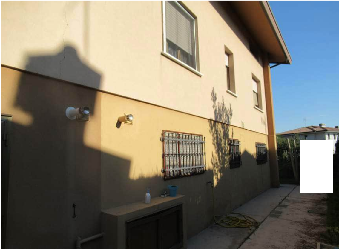
Foto 9: Prospetto Ovest fabbricato
