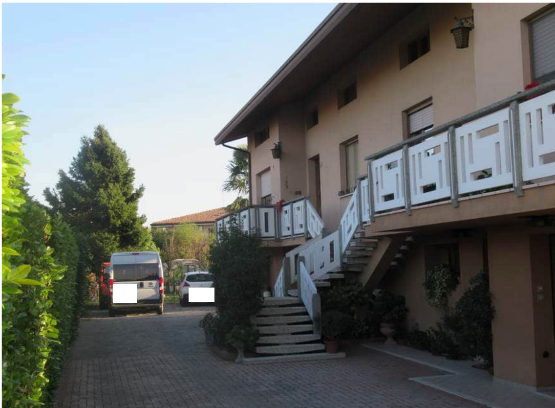
Foto 6: Servitù di transito prospiciente il fabbricato
