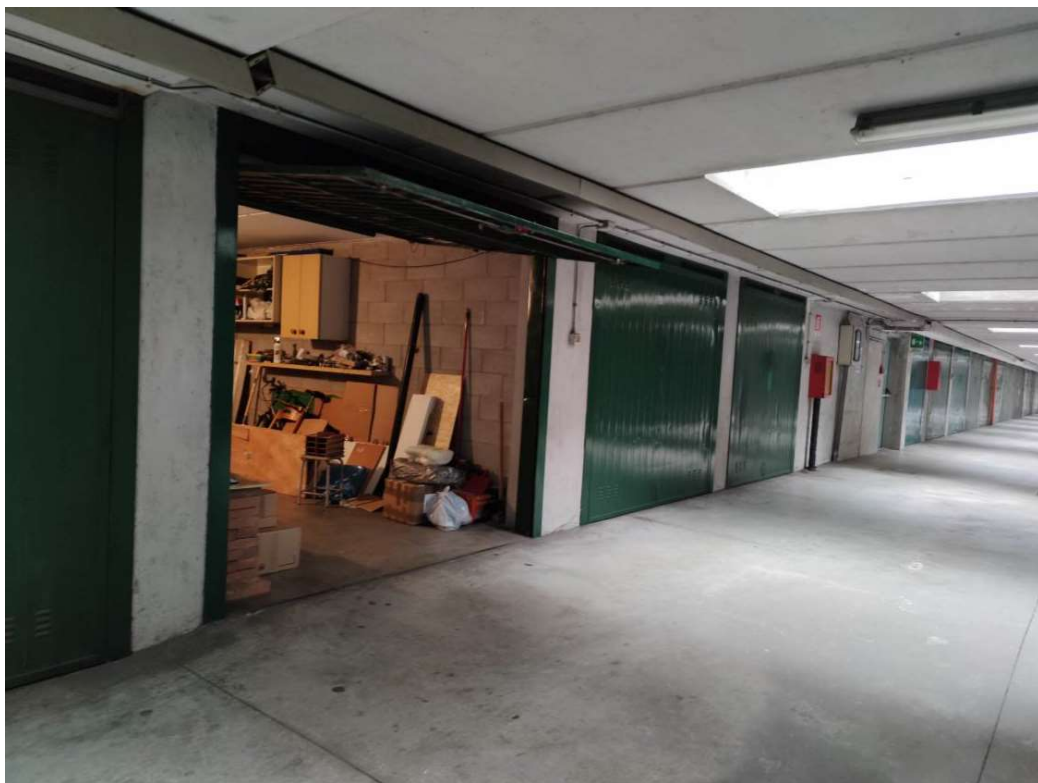
Immagine. 20. Ingresso box
