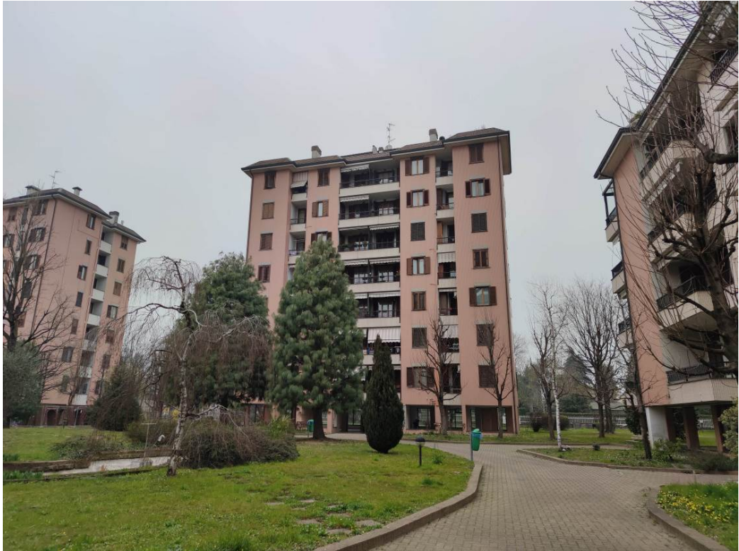
Immagine. 3. Vista edificio n. 5
