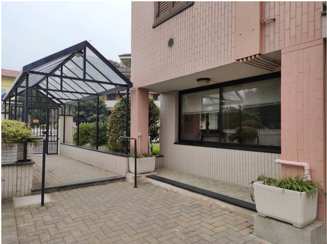
Immagine. 4. Ingresso al cortile e portineria (a destra nella foto).
