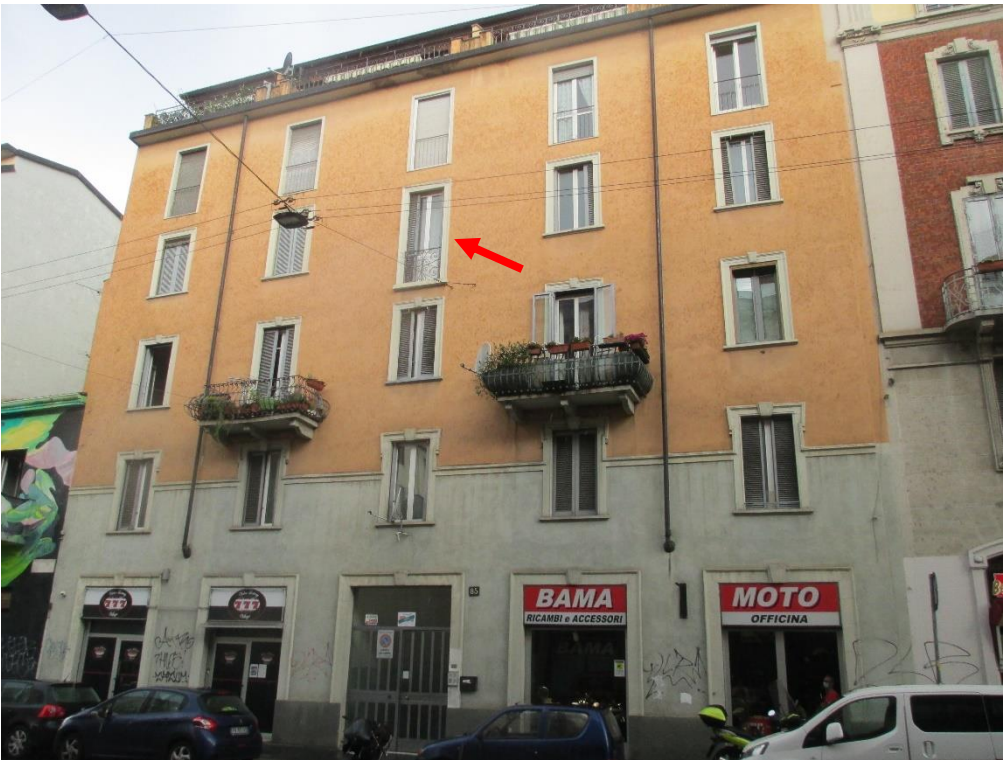
Foto 1: condominio via Padova 85
