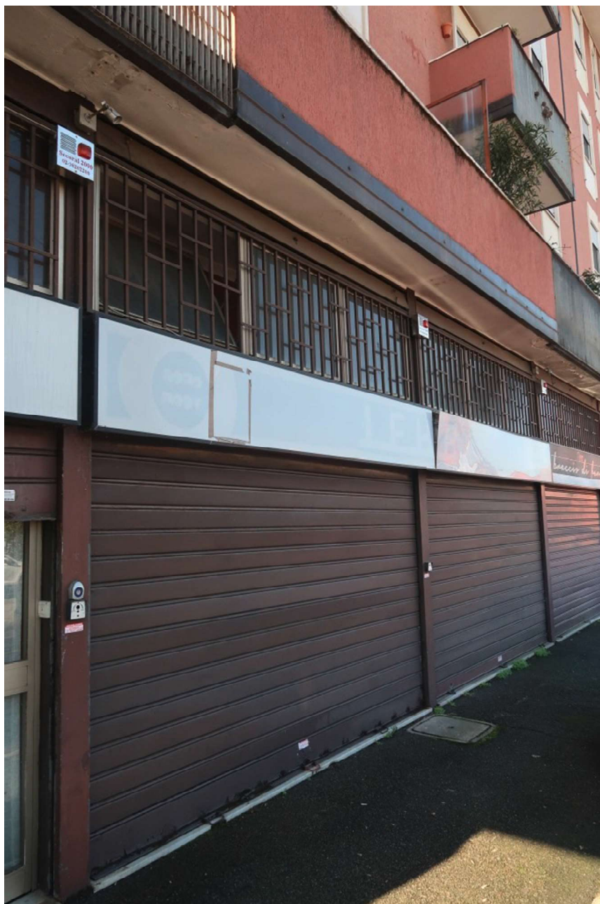
FACCIATA CON VETRINE
