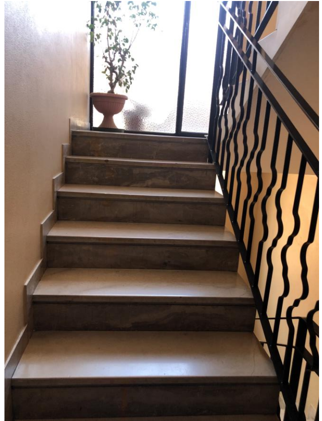
Vista vano scala comune
