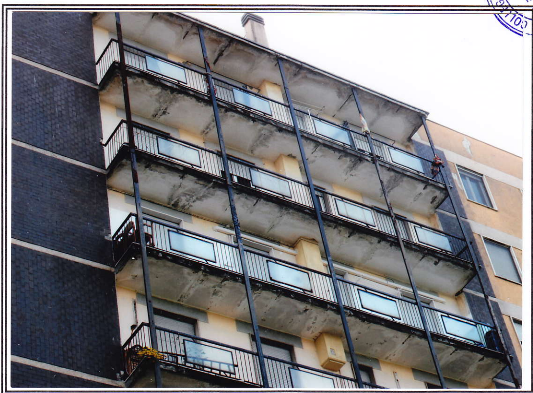
Esterno fabbricato scale "A" e "B" – dettaglio esterno appartamento
