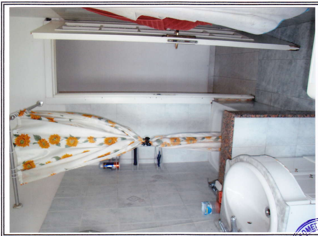
Interno appartamento – bagno
