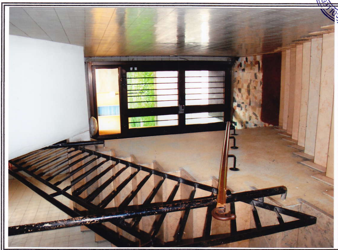
Interno fabbricato scala "B" – ingresso piano T e vano scala
