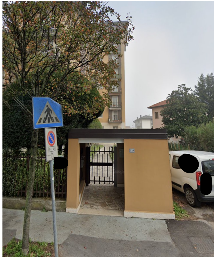
Foto n. 3 – Ingresso al condominio
