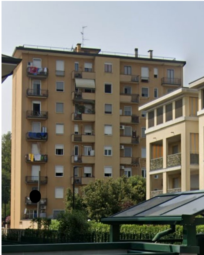
Foto n. 2 – Altro prospetto dell'edificio
