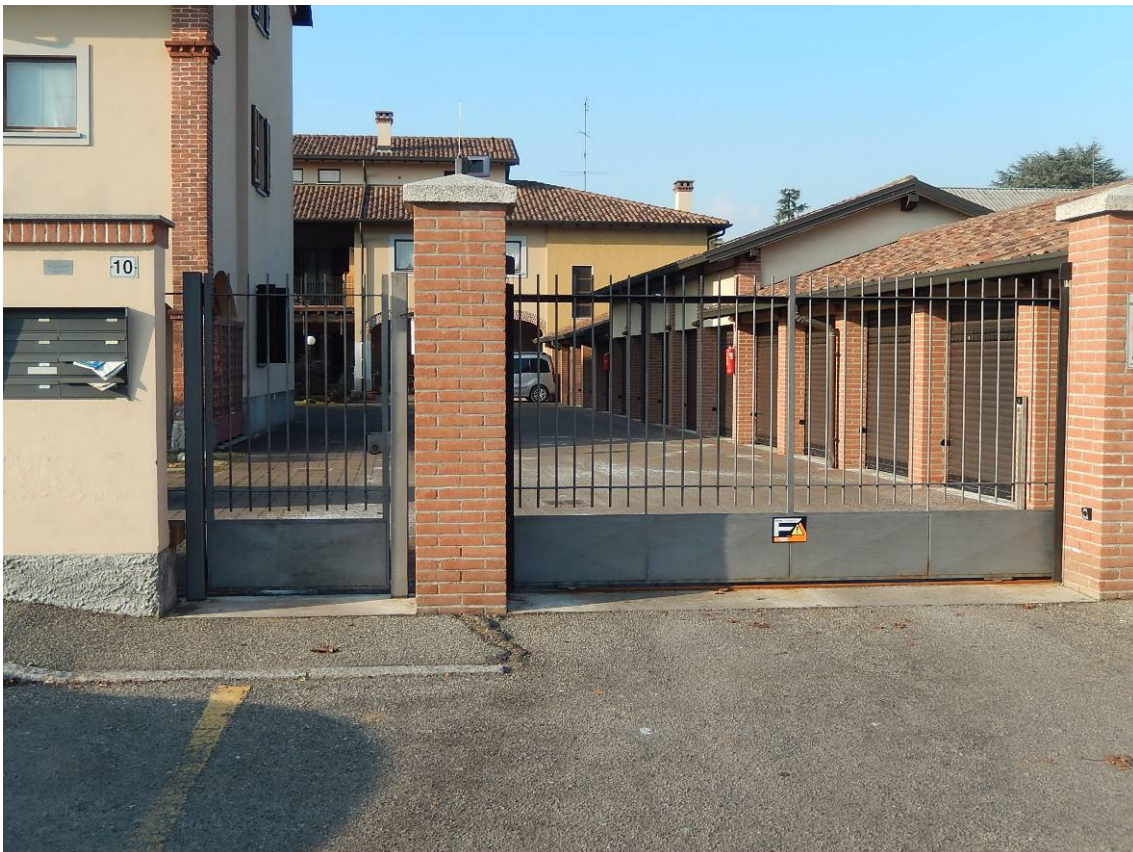
Foto 2 – Gli ingressi pedonale e carraio.
