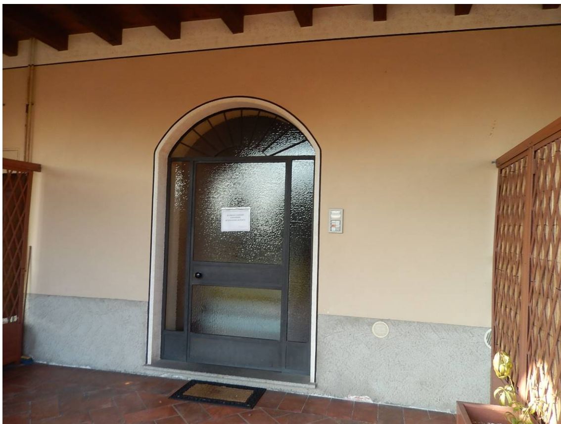
Foto 3 – Il portone di accesso al fabbricato.
