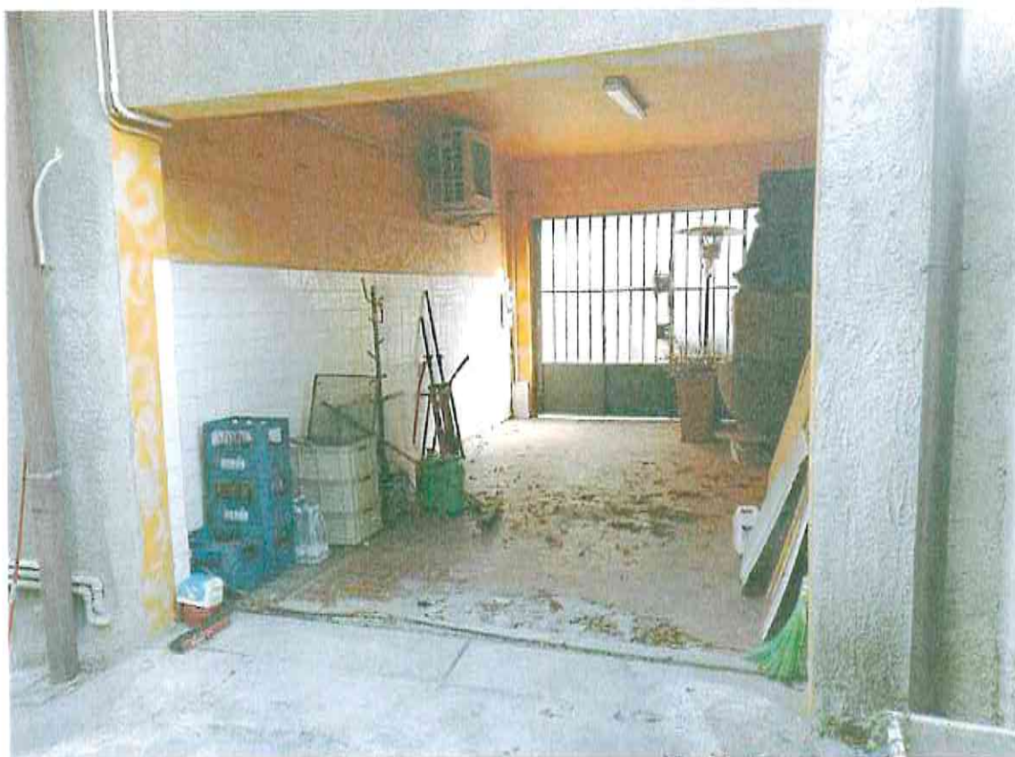
Vano accesso rampa da strada
