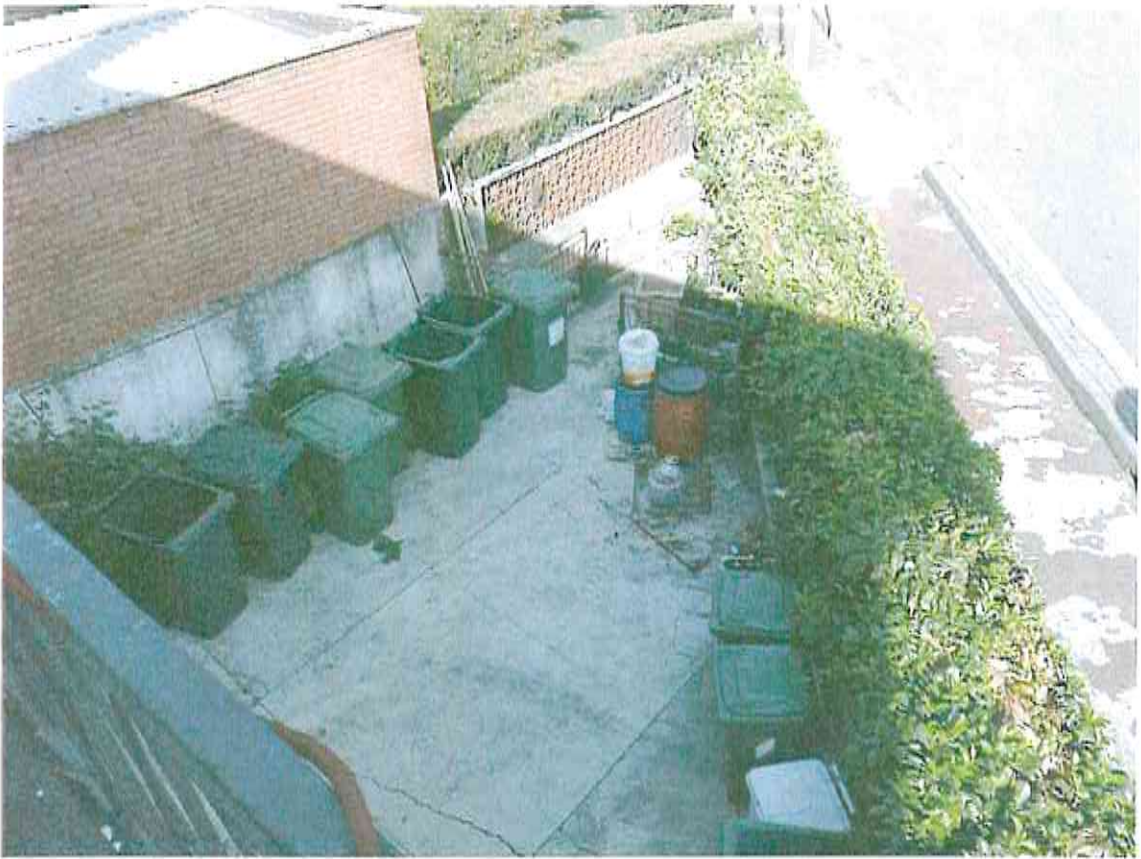
Cortile lato strada
