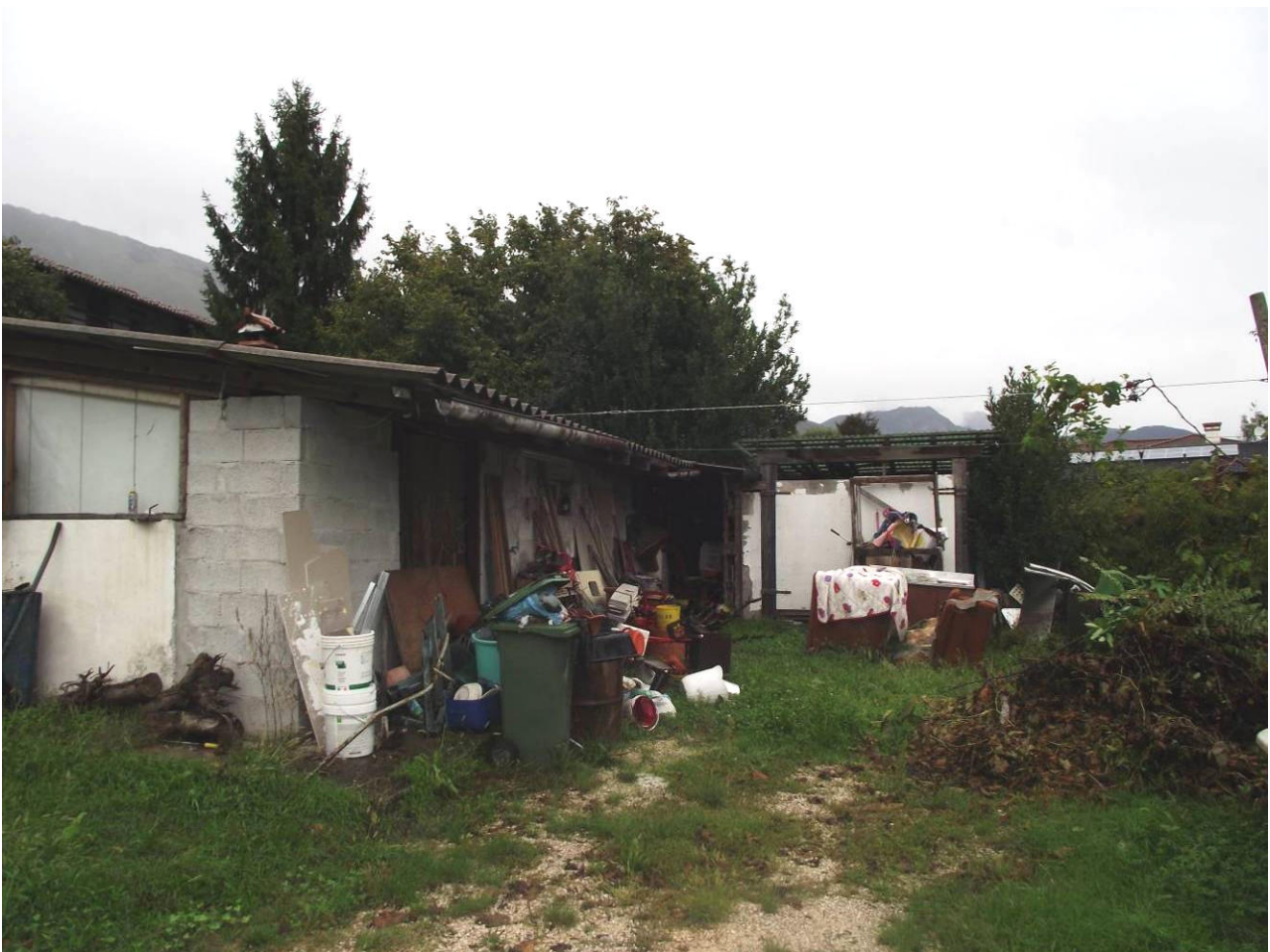
Foto 20 – Accessorio – prospetto posteriore e tettoia abusiva
