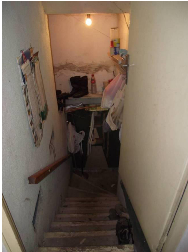
Foto 7 – Scala verso la cantina
