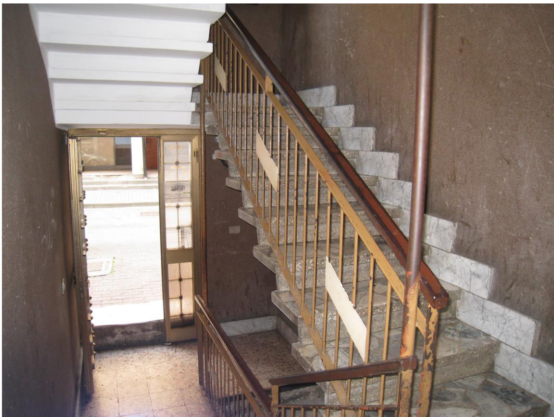
Vano scala comune
