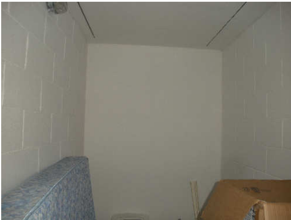
Fotografia 09 – Esempio di finitura interna di altra cantina
