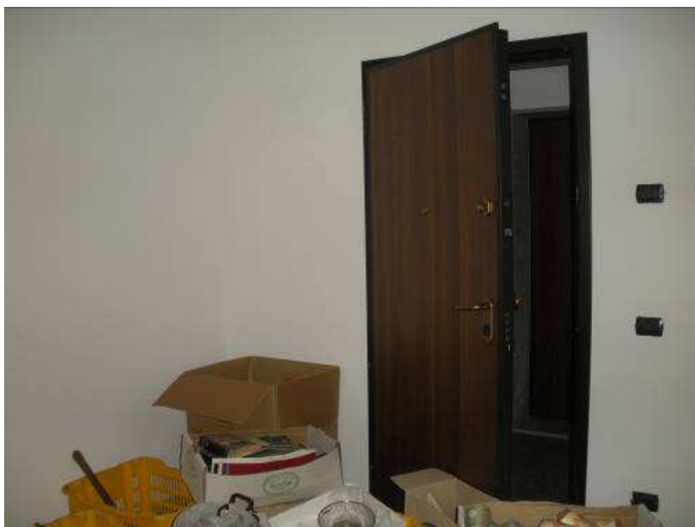
Fotografia 03 – Locale di ingresso/antibagno.
