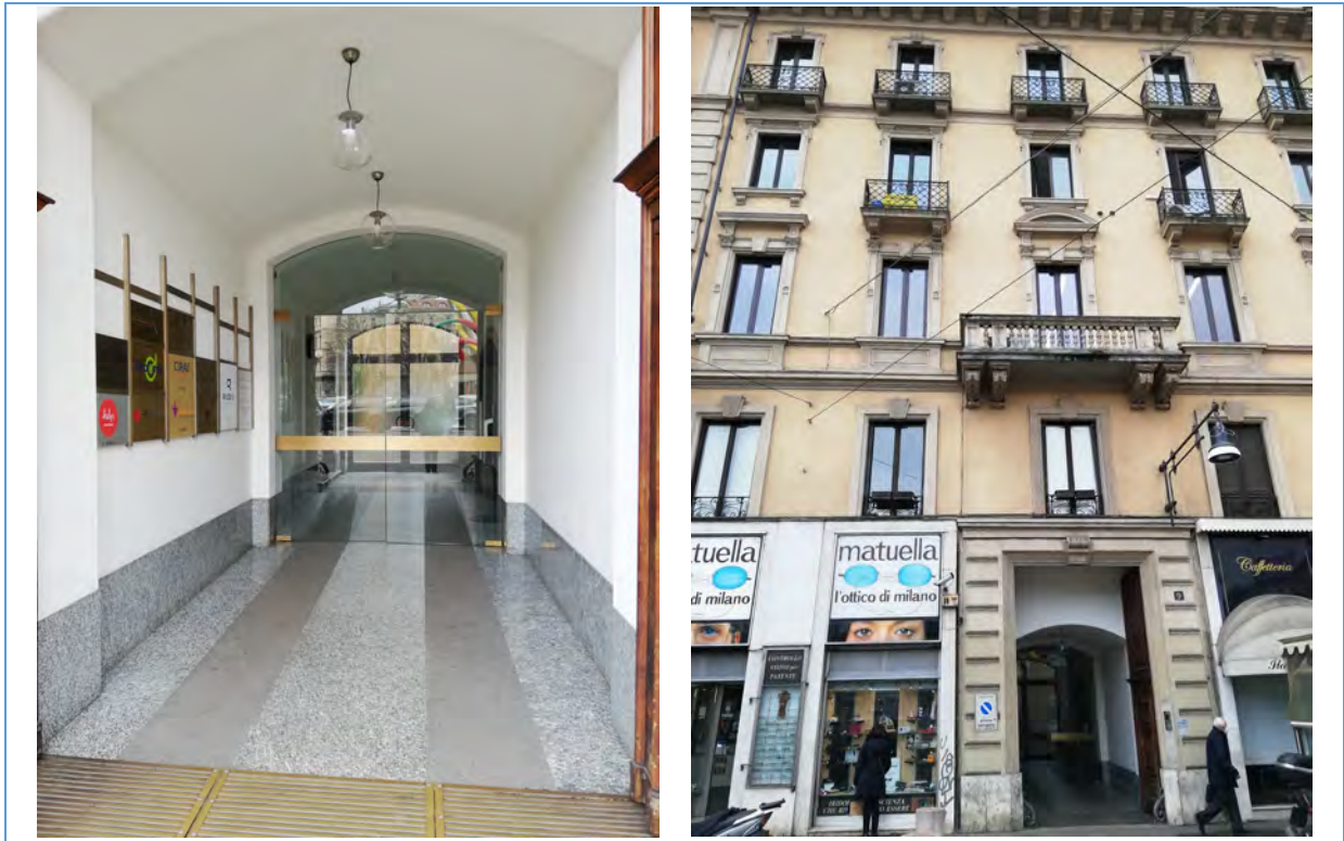
Vista fabbricato da piazzale Cadorna, accesso civico 9
