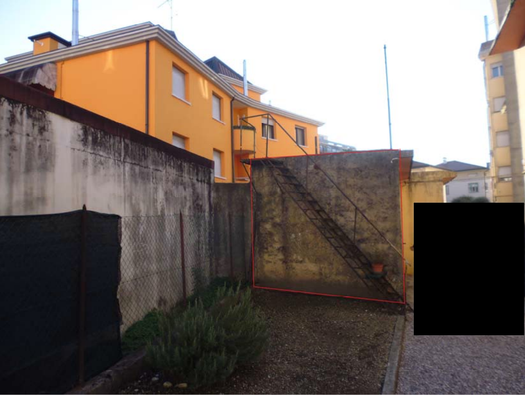
foto fabbricato lato nord
