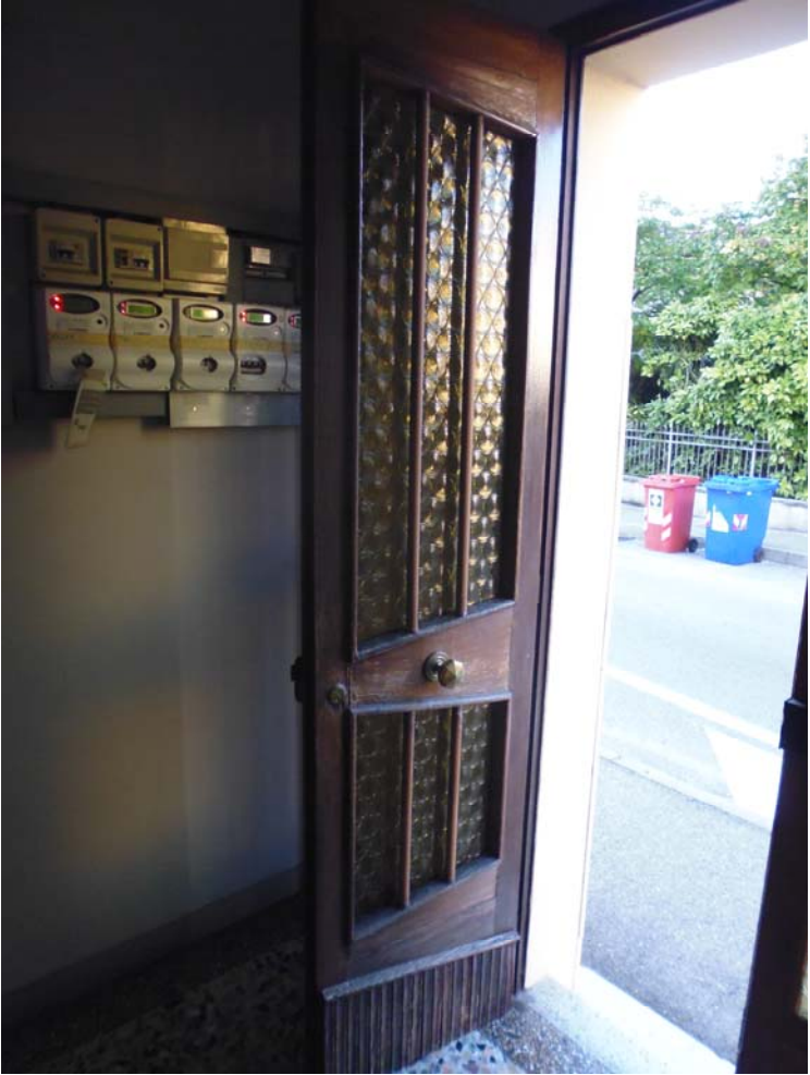
foto ingresso condominiale lato ovest
