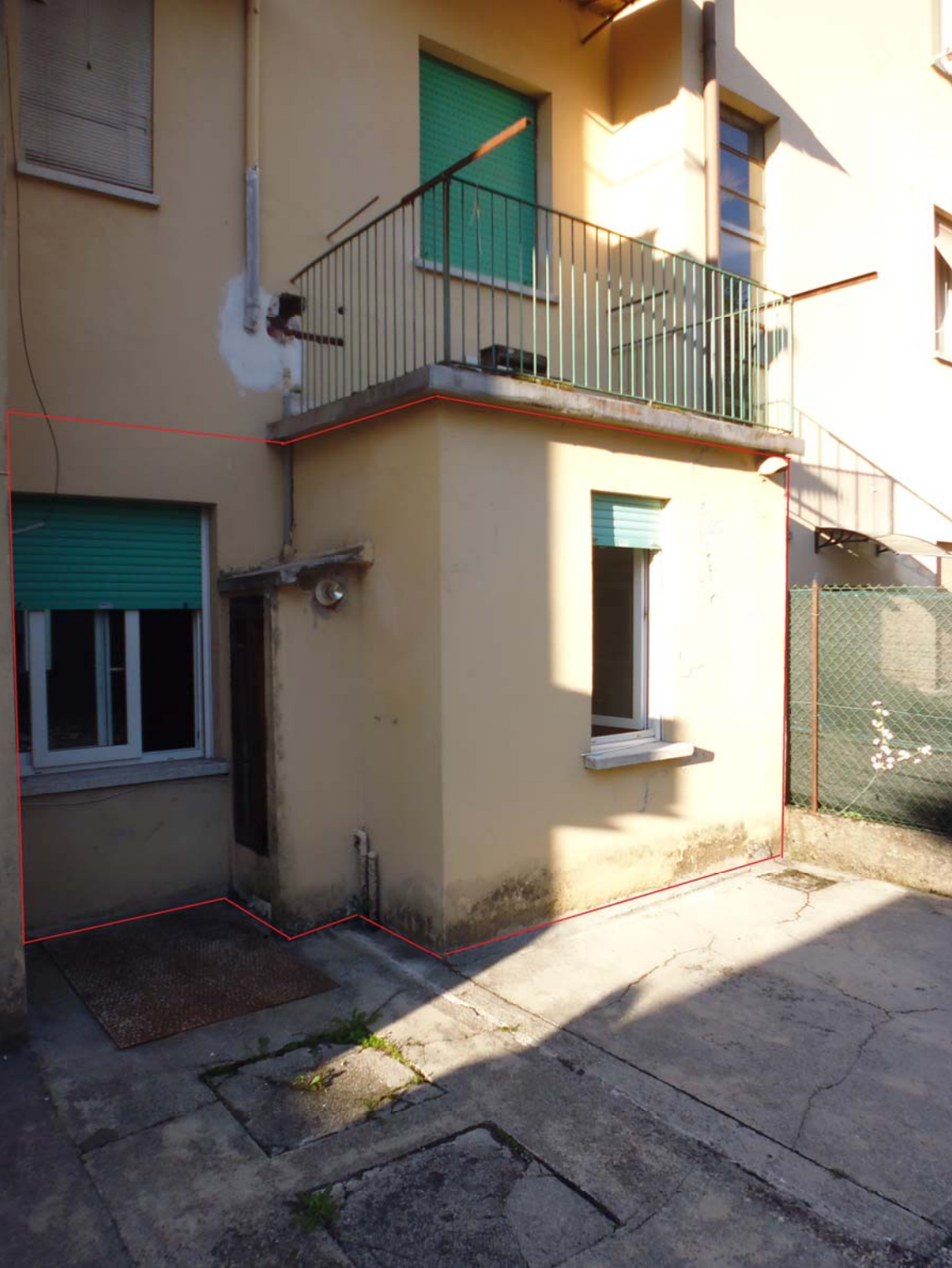
Porzione di facciata a nord – est dell'unità e vano caldaia
