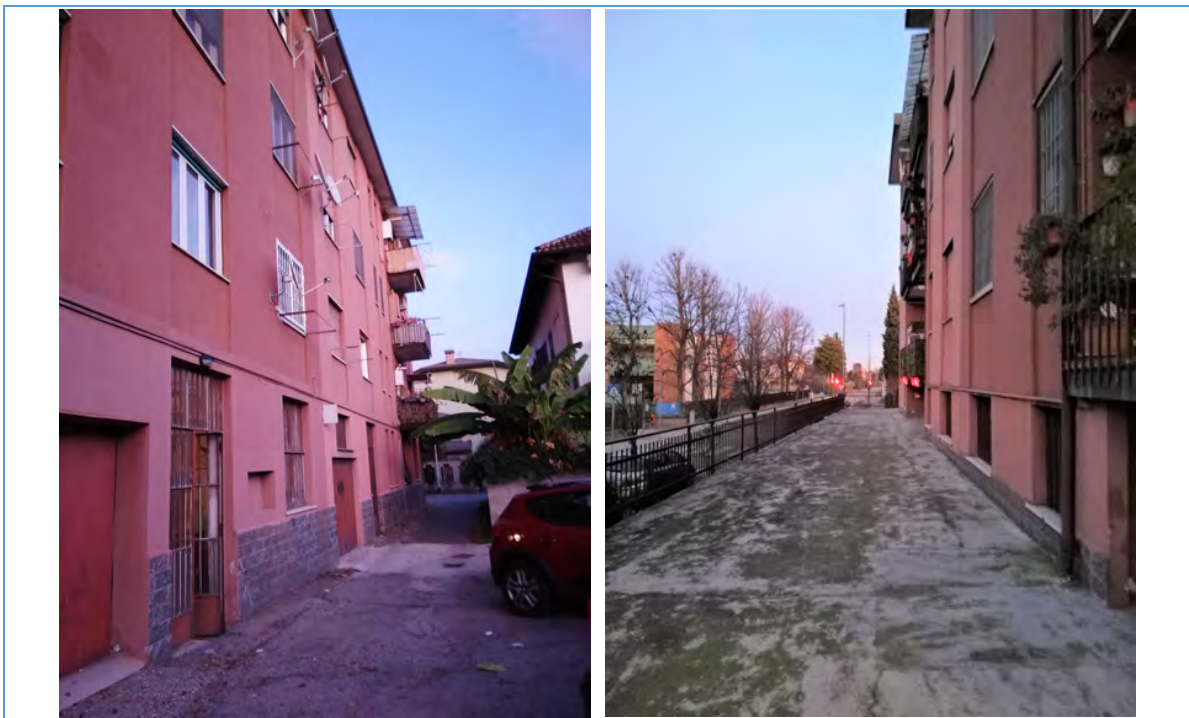
Fig. 4 - 5: vista posteriore fabbricato con accesso al cortile da via Stella, facciata anteriore con accesso principale via Milano
