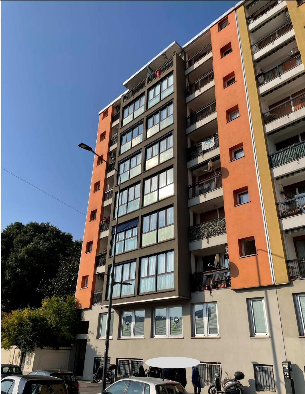
FOTO ESTERNA DEL FABBRICATO
