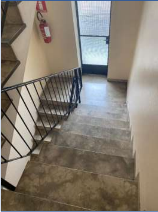
Foto 9 - vano scala comune
