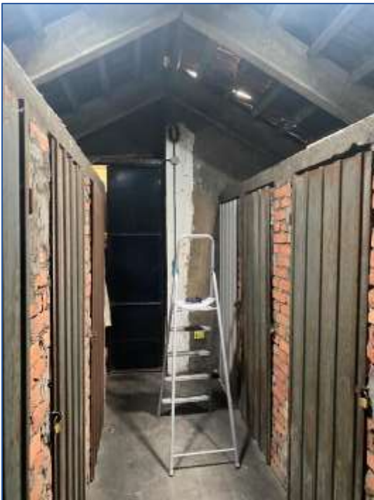
Foto 11 - spazi comuni piano sottotetto
