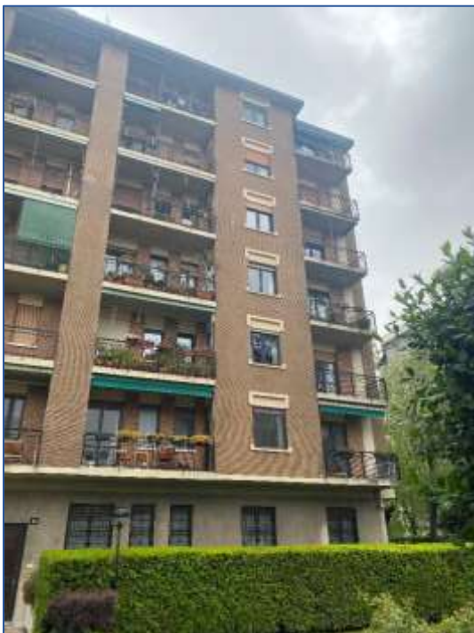
Foto 3 - immobile di via Zurigo n. 16
