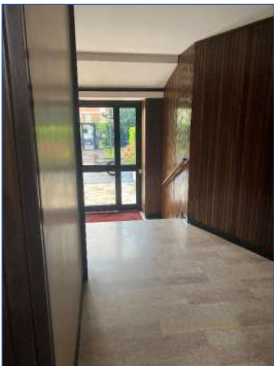
Foto 5 - spazi comuni di ingresso
