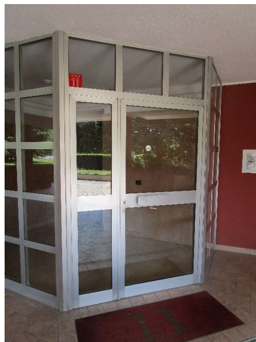
Accesso al fabbricato
