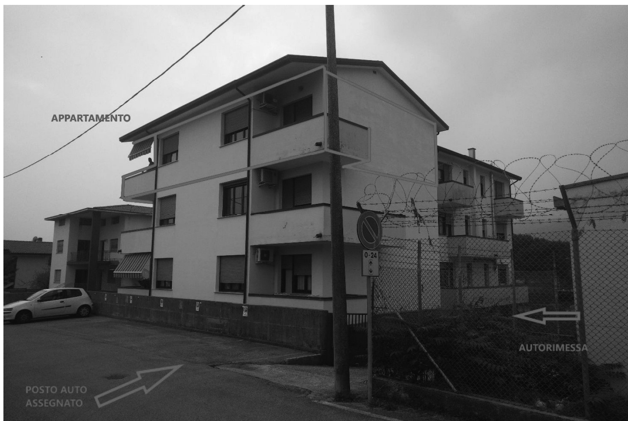
Foto n. 5 – Palazzina facciata fronte strada: in evidenza immobile esecutato (delimitato in rosso).
