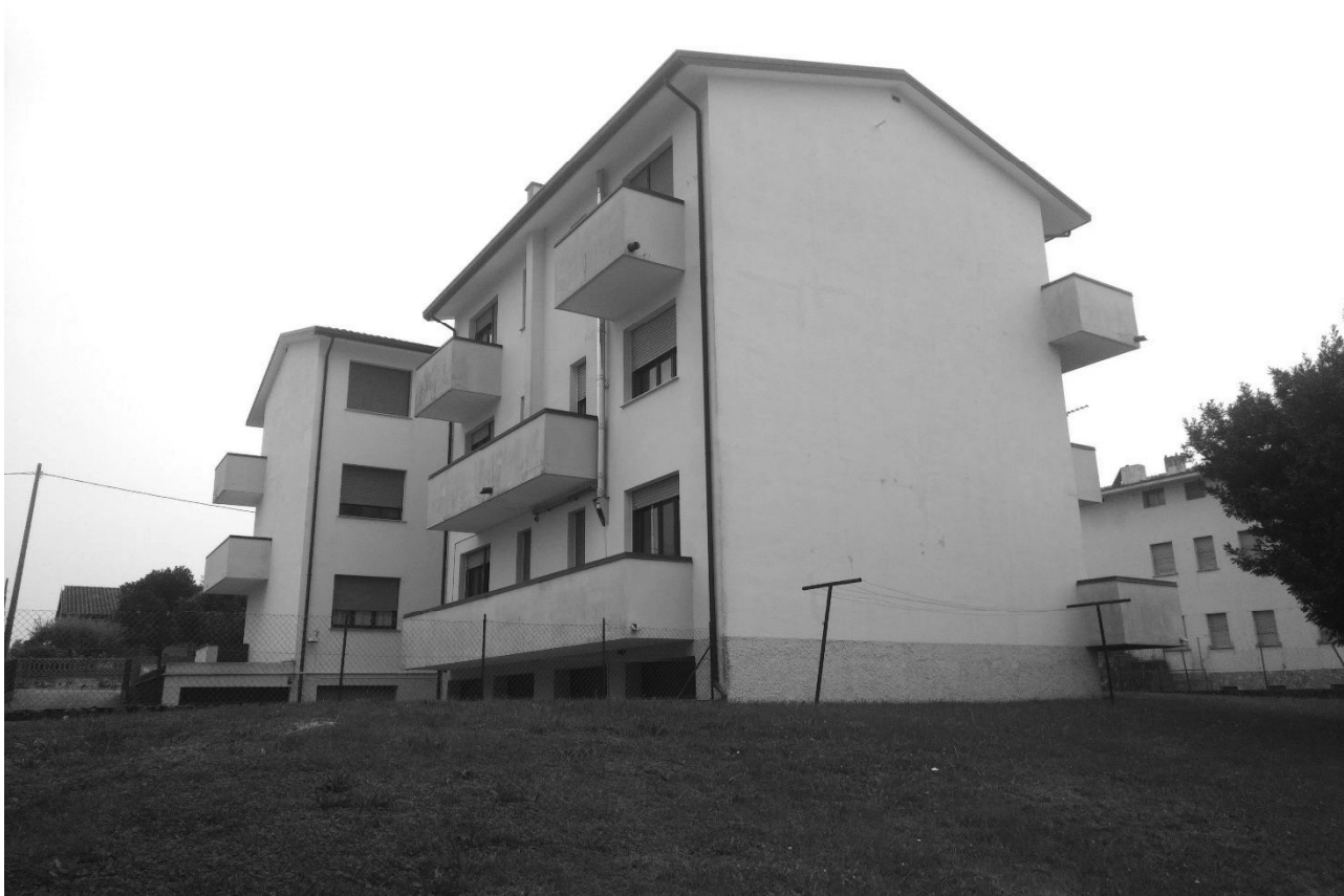
Foto n. 4 – Palazzina vista da scoperto condominiale (lato Nord - Est).
