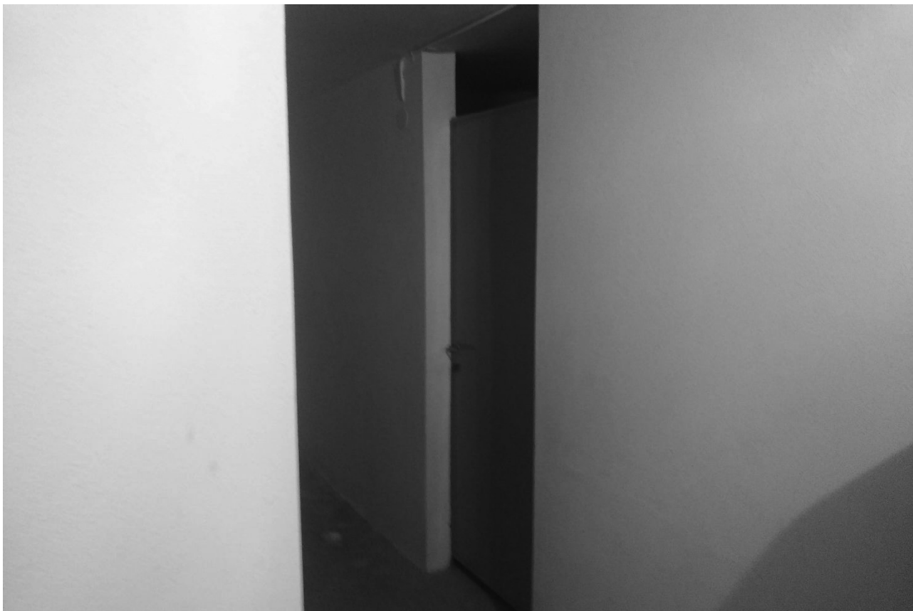
Foto n. 31 – Corridoio interrato che dà accesso alla cantina.
