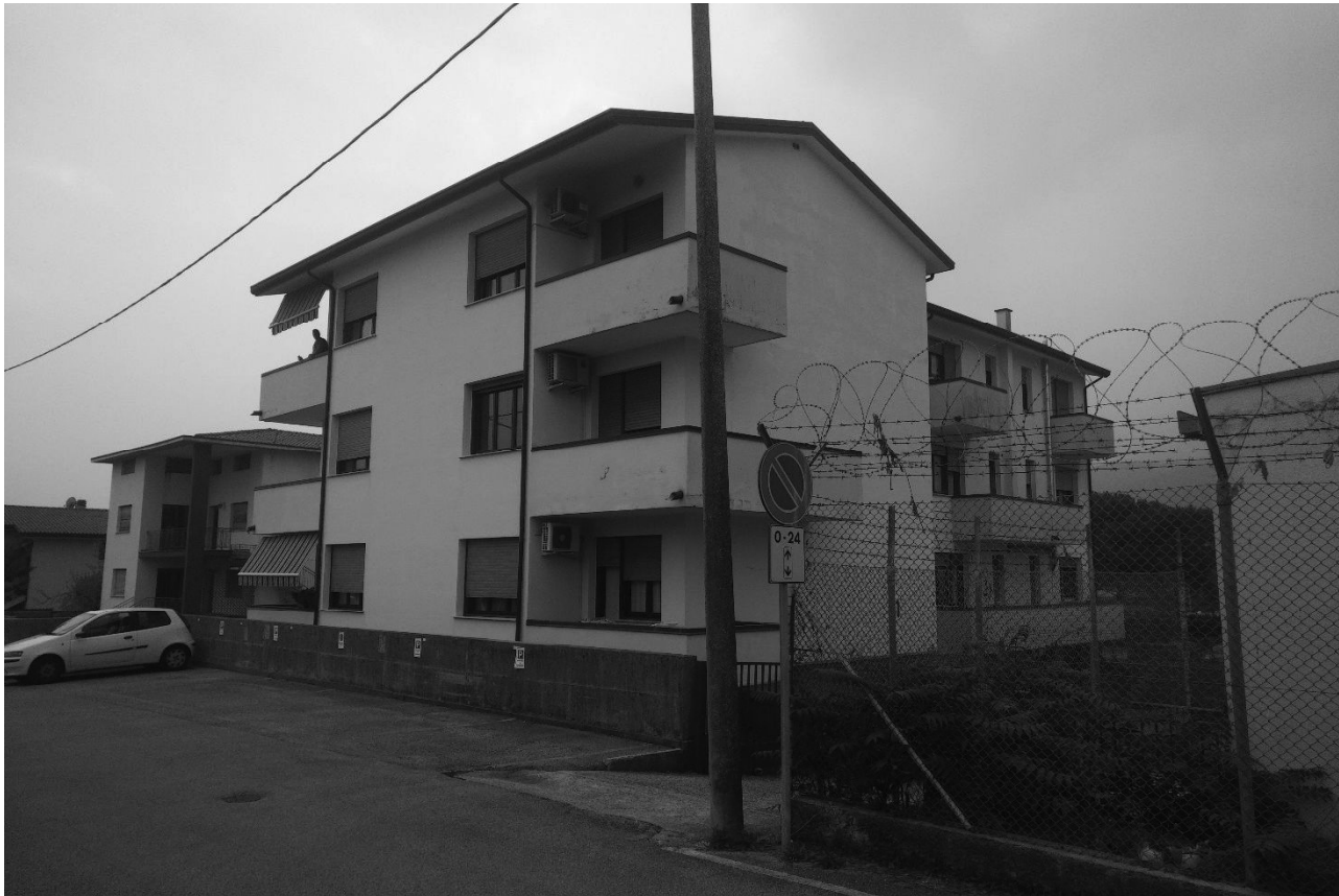
Foto n. 2 – Palazzina vista da via Monte Grappa (lato Sud - Est).
