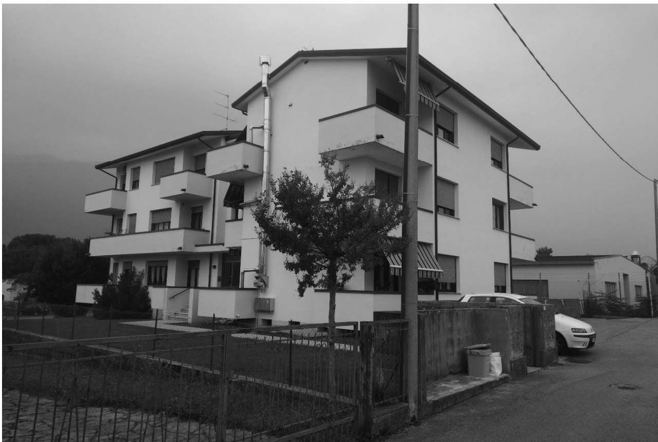
Foto n. 1 – Palazzina con vista da via Monte Grappa (lato Sud - Ovest).
