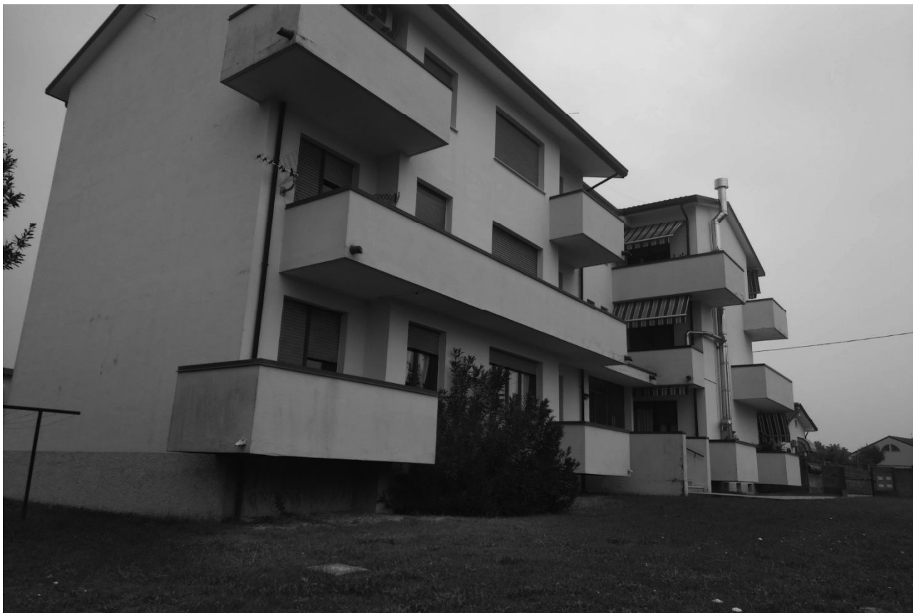
Foto n. 3 – Palazzina vista da scoperto condominiale (lato Nord- Ovest).
