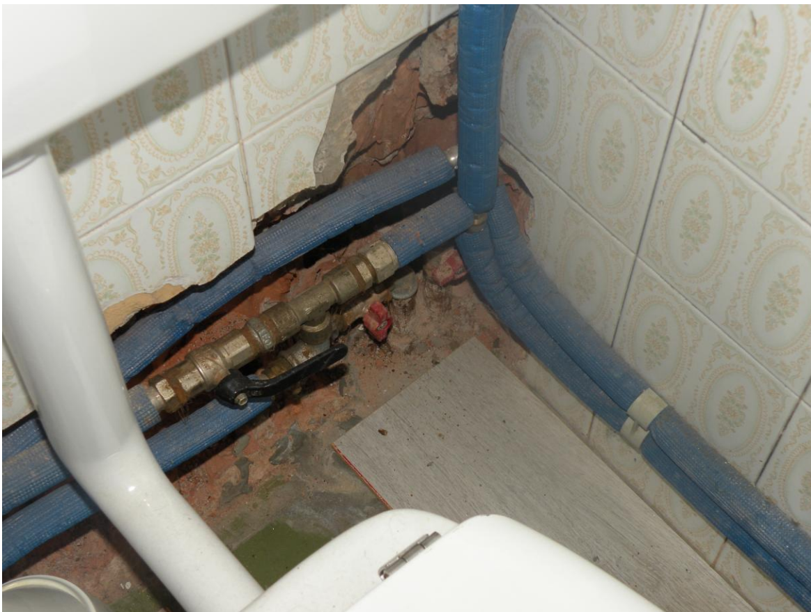
42 - particolare del bagno
