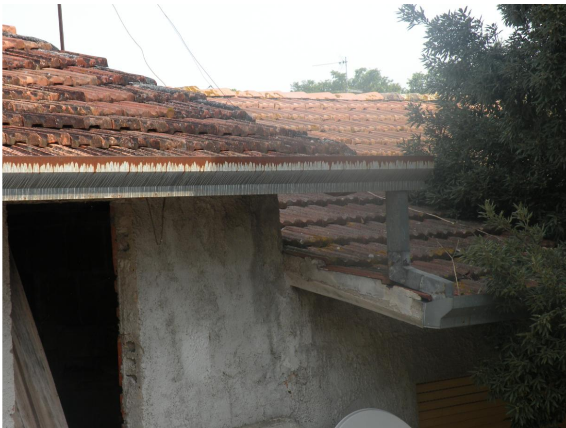
52 - manto del tetto
