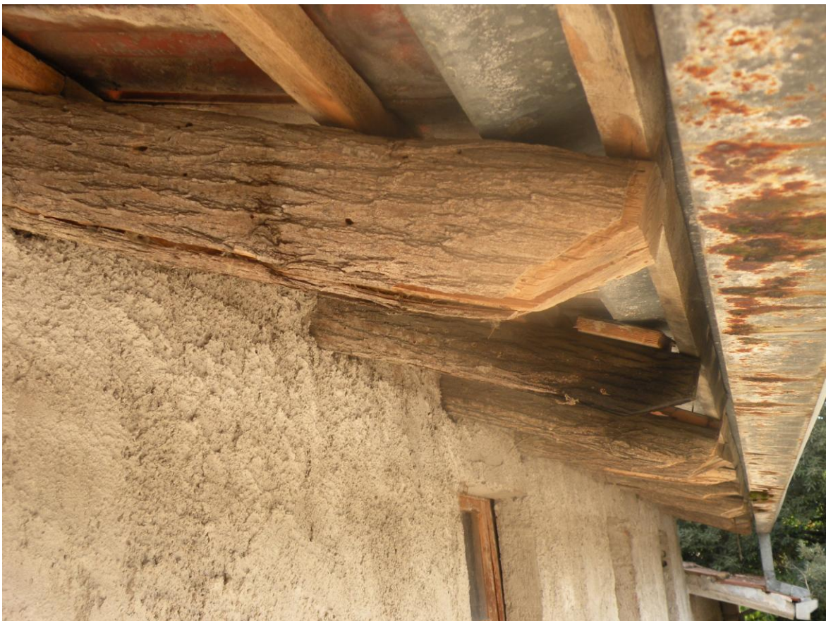
51 - particolare del tetto della soffitta
