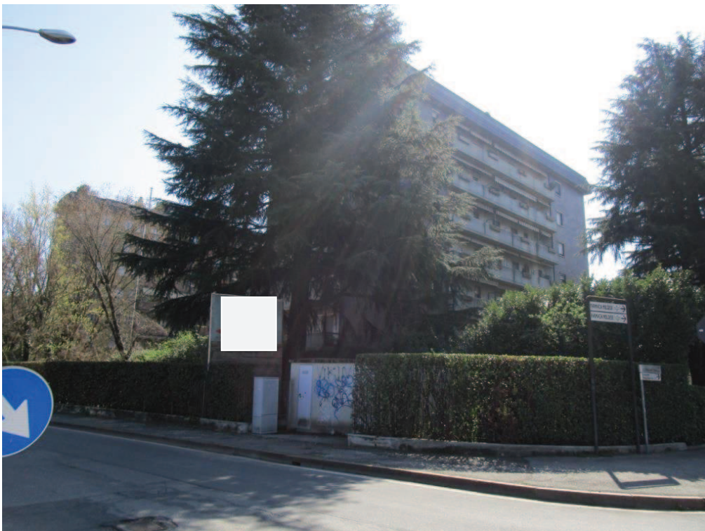
Foto 6 – Vista da via Olanda, angolo via Monte Santo, della particella 178
