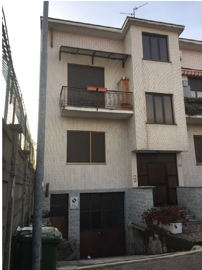
Foto 04 - Il fabbricato su via Contardo Ferrini al civico 28
