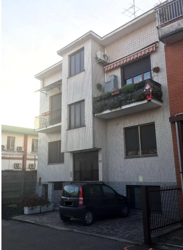
Foto 03 - Il fabbricato su via Contardo Ferrini al civico 28
