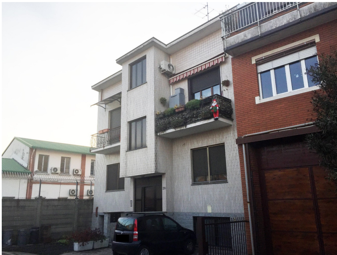
Foto 01 - Il fabbricato su via Contardo Ferrini al civico 28
