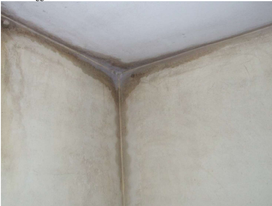
Foto 10: problemi di infiltrazioni risolti
