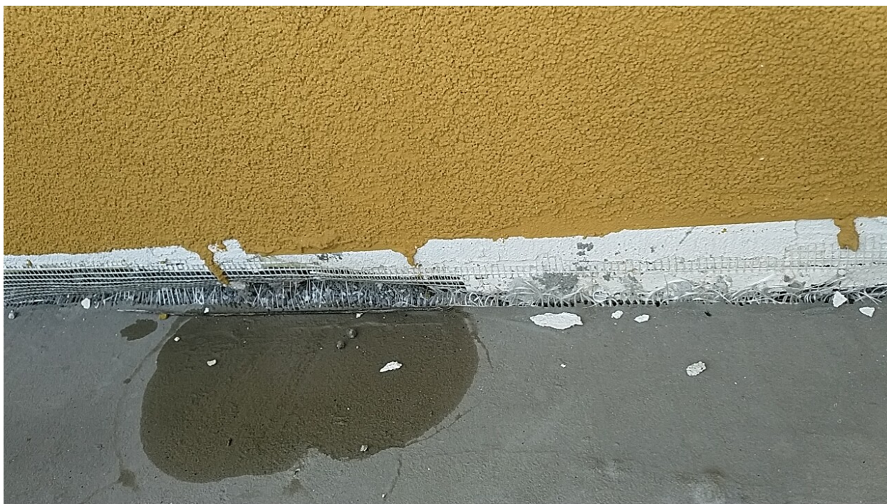
Sesto al Reghena, via Buse – Sopra particolare dei collettori dell'impianto idrico, sotto particolare del raccordo tra pavimento e parete in corrispondenza del terrazzino esterno
