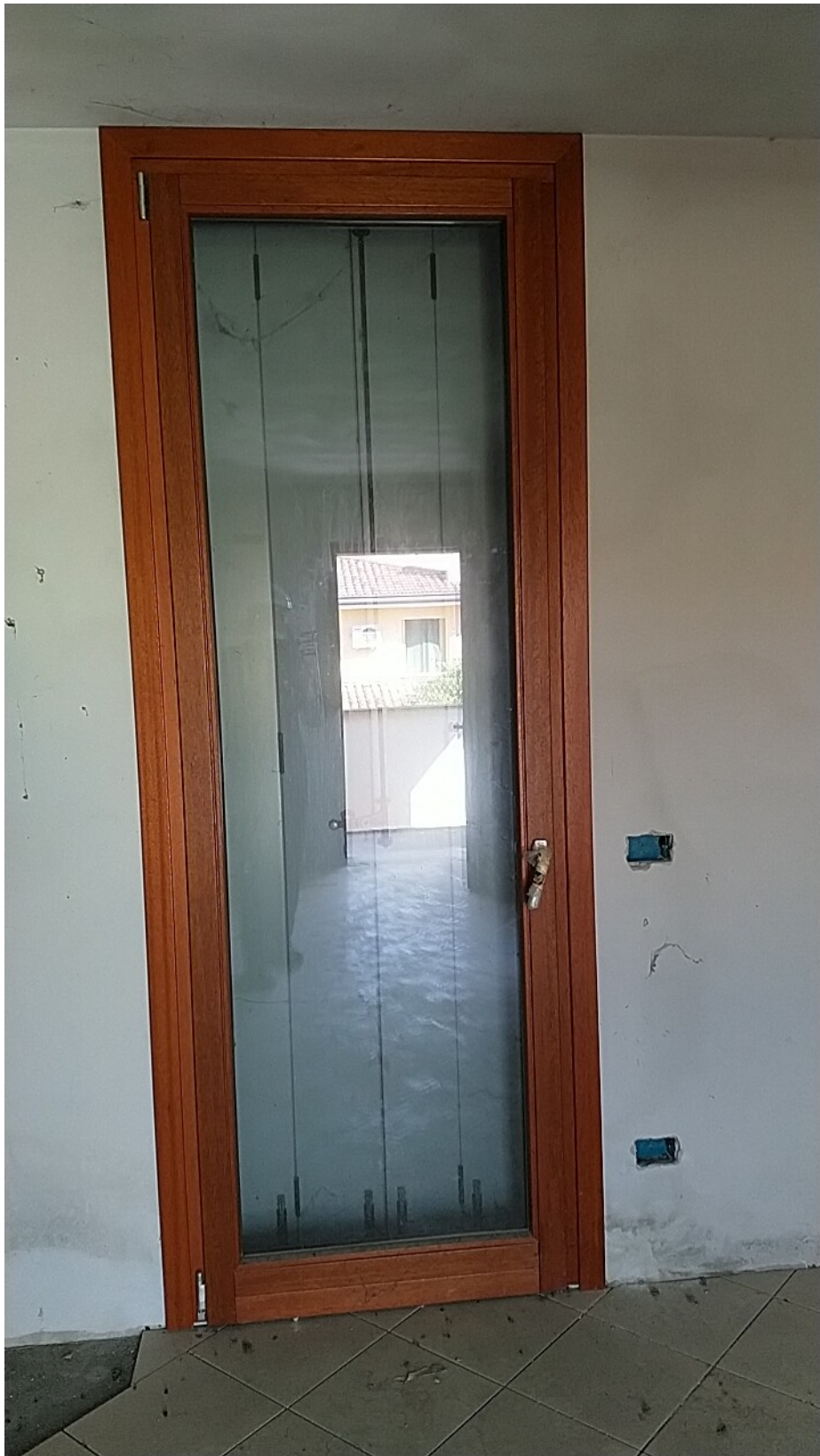
Sesto al Reghena, via Buse – Particolare degli infissi.
