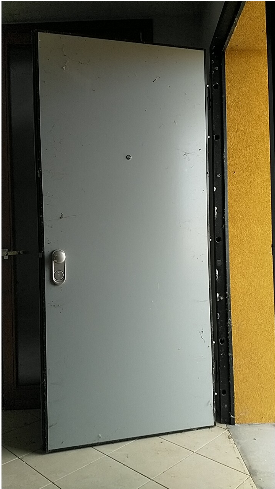
Sesto al Reghena, via Buse – Particolare della portoncino blindato.
