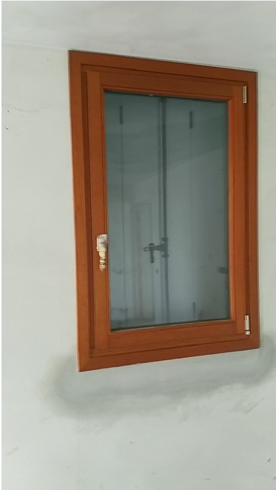
Sesto al Reghena, via Buse – Particolare dell'infisso.
