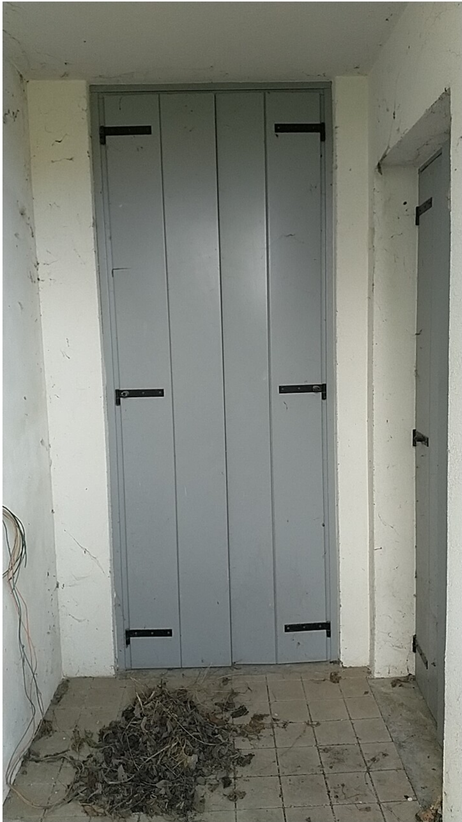
Sesto al Reghena, via Buse – Particolare degli scuri.
