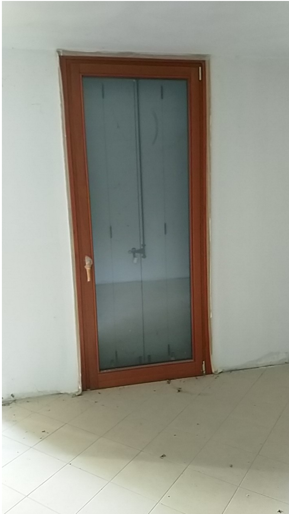
Sesto al Reghena, via Buse – Particolare degli infissi.
