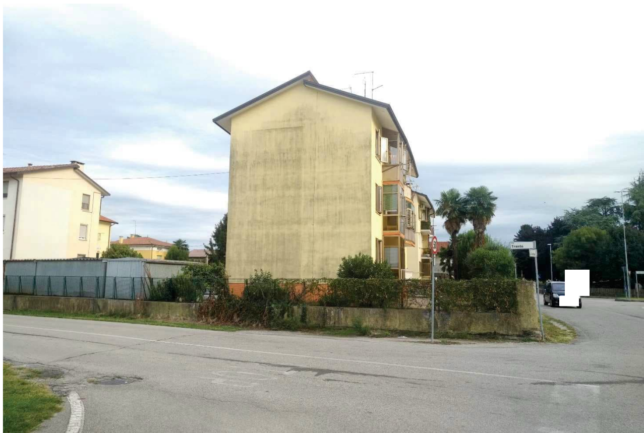
Foto n. 2 – Palazzina vista da via Trento (lato Nord).
