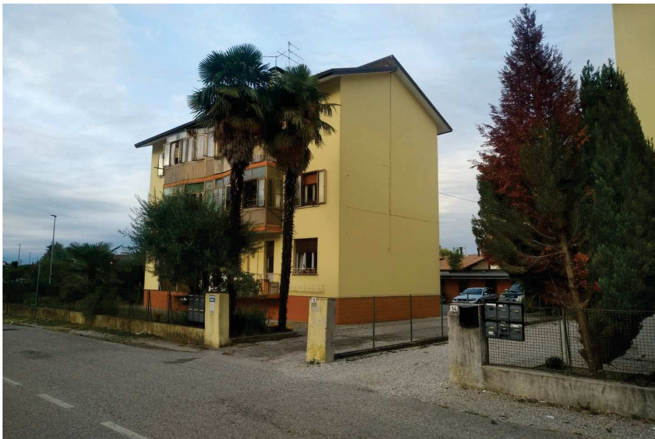
Foto n. 3 – Palazzina vista da via L. Carminati (lato Sud - Ovest).
