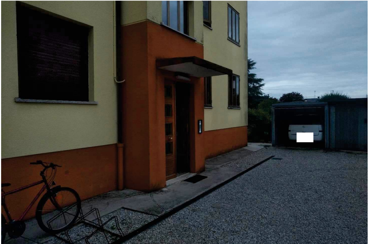
Foto n. 6 – Ingresso condominiale (posto ad est, su cortile interno).
