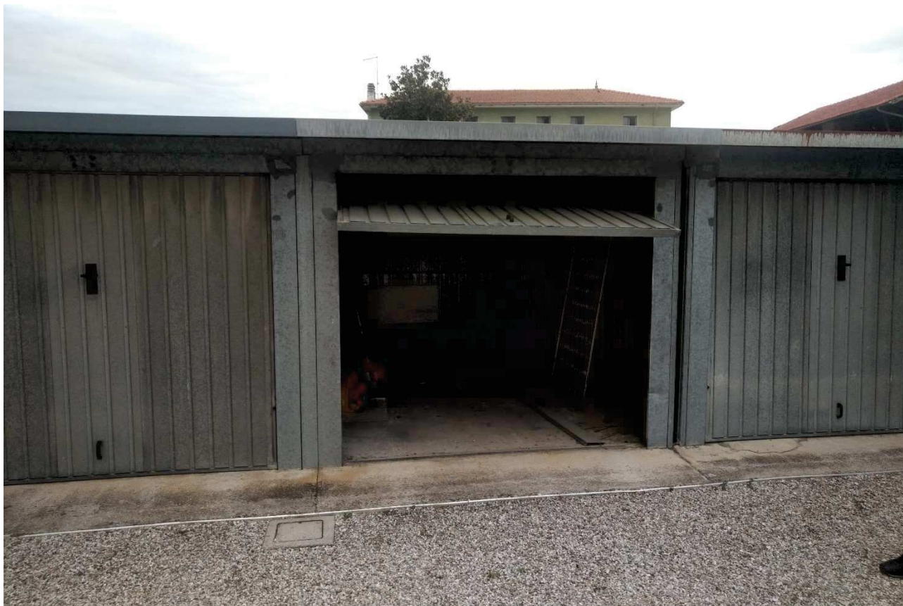
Foto n. 25 – Autorimessa con vista interna.
