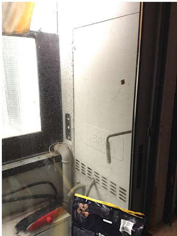
FOTO 20 - 22 – CALDAIETTA E CANTINA DI PERTINENZA
