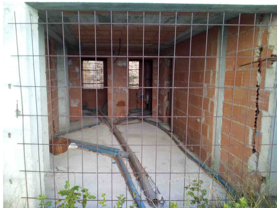
Veduta autorimessa p. terra
