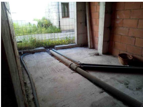
Veduta autorimessa p. terra
