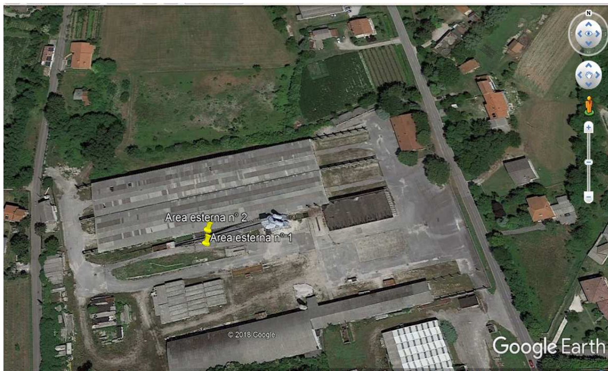
Fig. 9 – Ortofoto posizionamento aree esterne con frammenti di eternit
