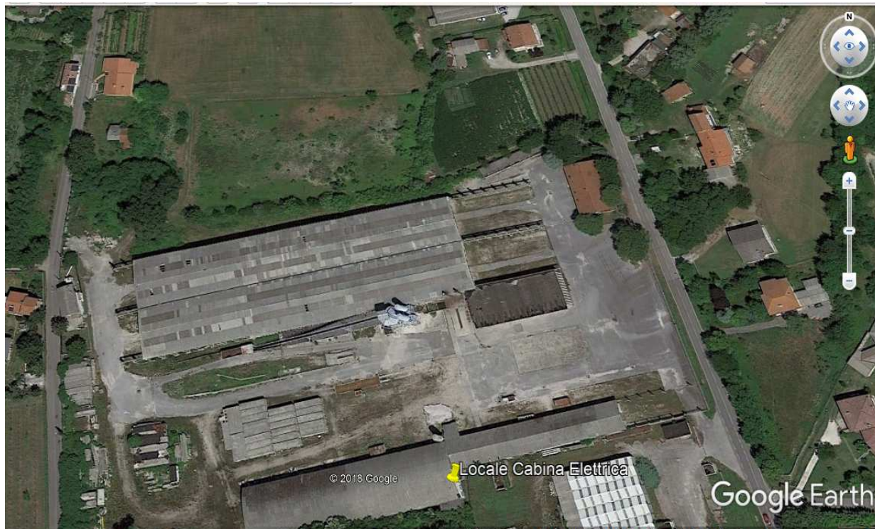
Fig. 7 – Ortofoto posizionamento trasformatore
