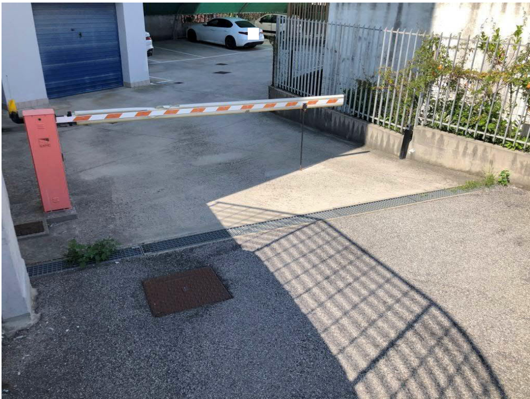
VISTA ESTERNA DELL'ACCESSO AI POSTI AUTO
