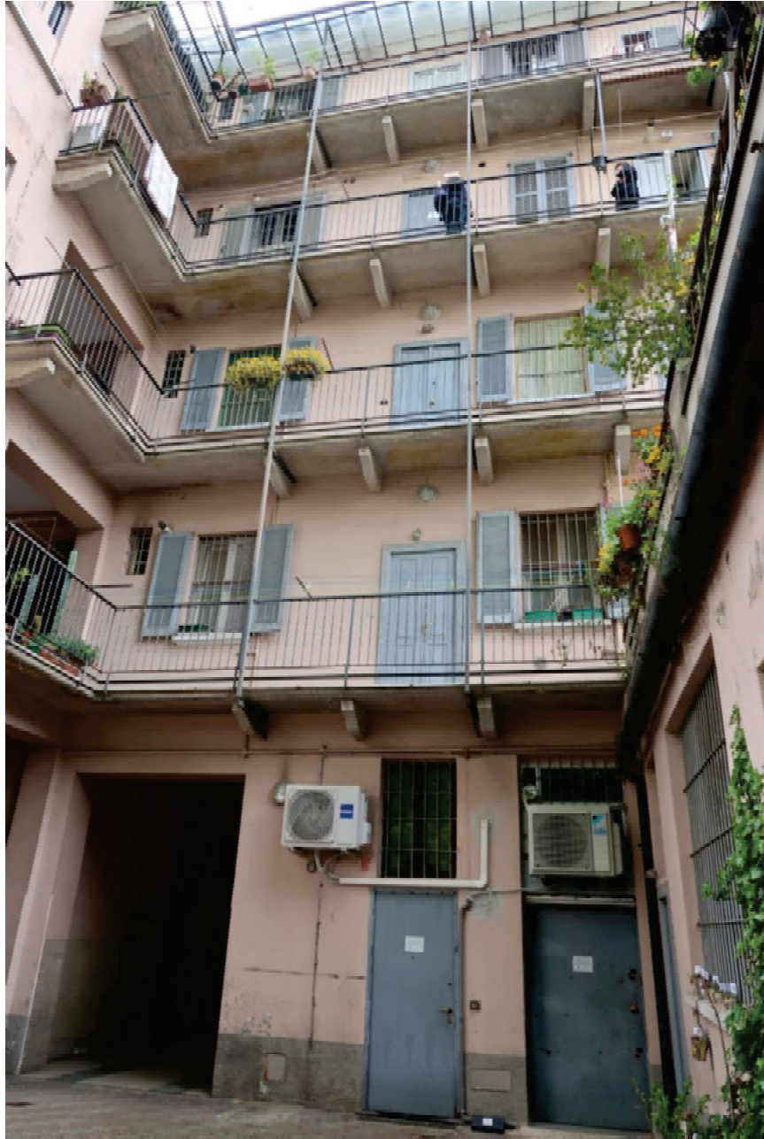
FACCIATA SU CORTILE INTERNO
