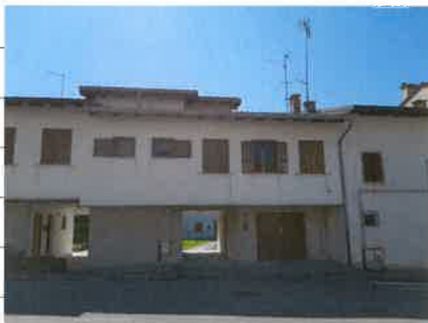
Immobilie principali distinte catastalmente al Foglio 10 Particella 597 Subalterno 4 e 5
