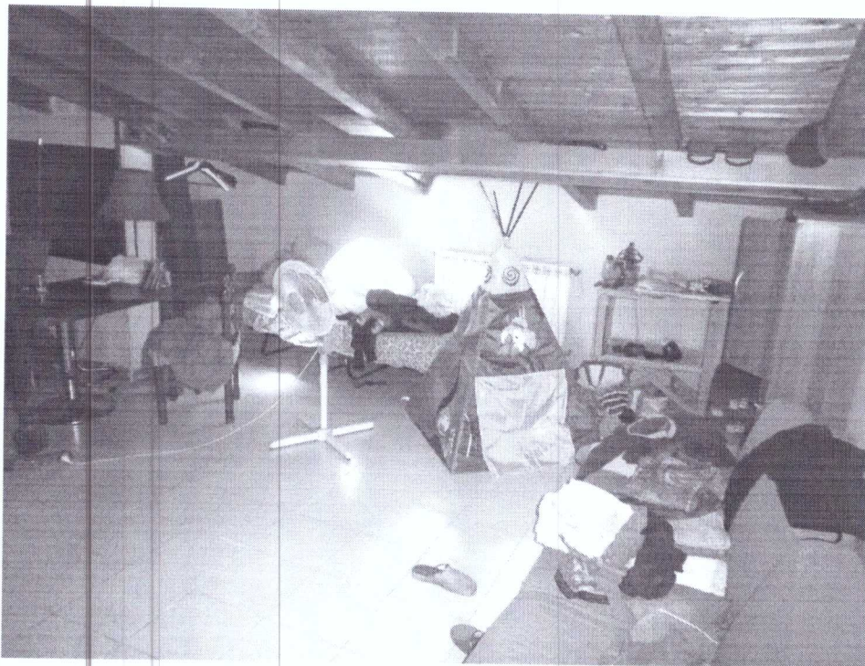
- FOTO 39 - VANO SOTTOTETTO 2 -
