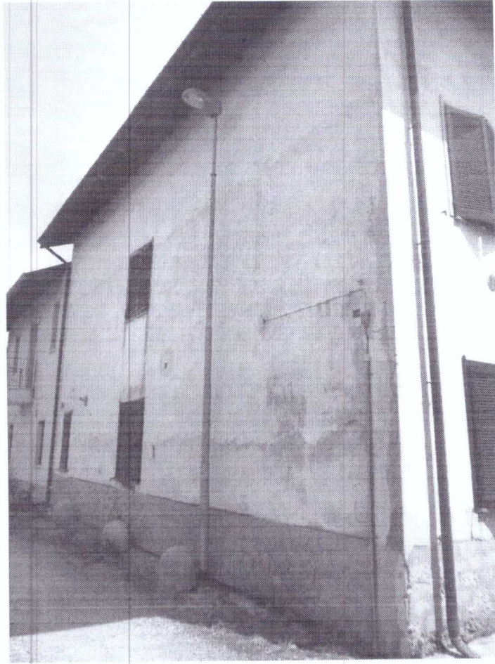
- FOTO 3 - FACCIATA NORD SU VIA SANTO STEFANO -
