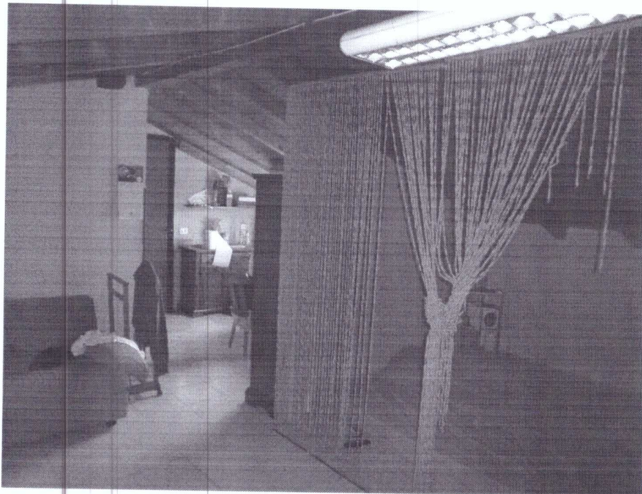
- FOTO 43 - VANO SOTTOTETTO 2 -
