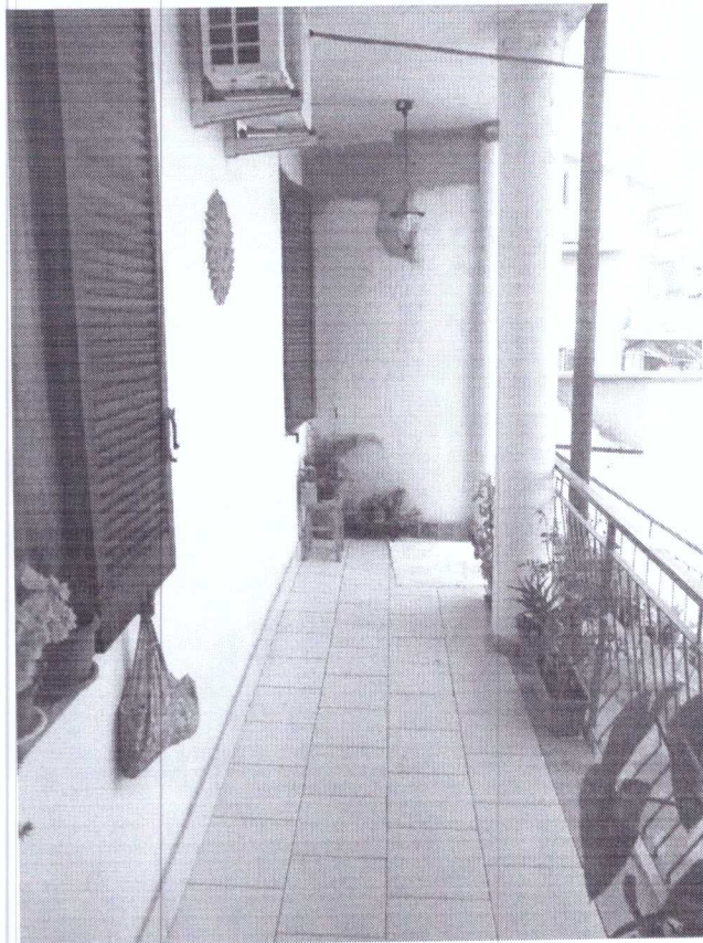
- FOTO 7 - BALCONE SU CORTILE INTERNO -
