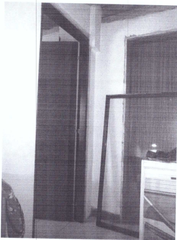
- FOTO 34 - PORTA DI ACCESSO AL VANO SOTTOTETTO 2 E PORTA COMUNICANTE CON IL VANO SOTTOTETTO 1 -
