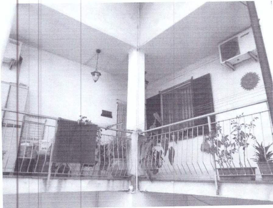
- FOTO 4 - FACCIATE EST E SUD SU CORTILE INTERNO -
