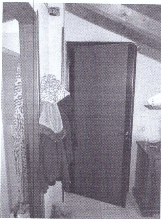
- FOTO 35 - INGRESSO DEL VANO SOTTOTETTO 2 -
