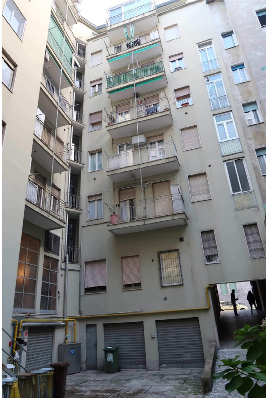
FACCIATA SU CORTILE INTERNO
