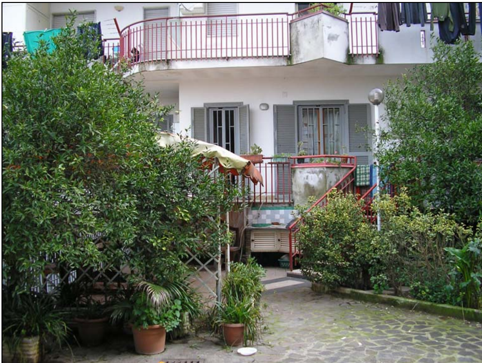
Fotografia n. 2 – Esterno del fabbricato lato cortile condominiale
