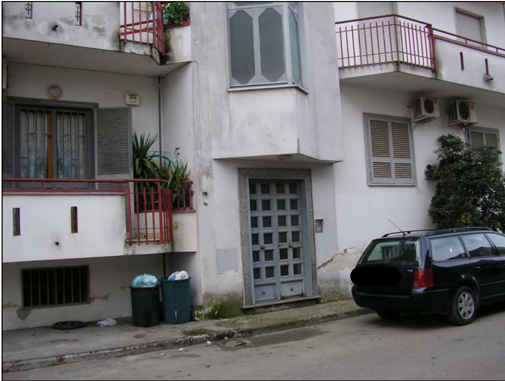
Fotografia n. 1 – Esterno del fabbricato lato ingresso
